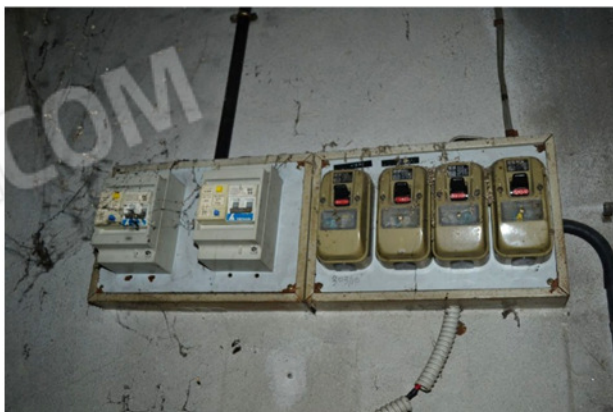
foto 15 - sub 1 (loc. boiler) - Il quadro elettrico as-servito al secondo vano tecnico ha due differenziali (uno per la caldaia e l'altro per lo scaldacqua) di corretta taratura e quattro obsoleti magnetotermici.
