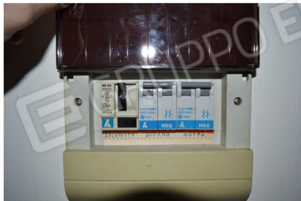
foto 21 - sub2 (ingresso) - Il quadro elettrico generale alloggia un differenziale di corretta taratura, con I_{\Delta n} = 0.03 \text{ A} , e due magnetotermici: uno per la zona giorno, da 15 A, e l'altro per la zona notte, da 10 A. Nessuno degli impianti tecnologici risulta munito della dichiarazione di conformità, introdotta con la Legge n. 46/90, cioè molto dopo l'agibilità dell'edificio.
