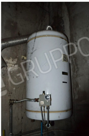
foto 18 - sub 1 (boiler) - Lo scaldabagno a metano, avente circa cento litri di capienza utile, è marca Boschetti con sensore bitermostatico incorporato. Il tubo fummi è fuori servizio e non si vedono adduzioni dirette, per cui è lecito supporre che il serbatoio funzioni come un puffer sanitario.
