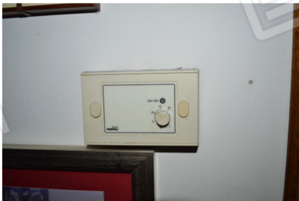
foto 13 - sub 2 (ingresso) - Gli unici due cronotermostati rilevabili si trovano nel vestibolo (quello in foto) e nel bagno, definendo così due zone termiche distinte. Si tratta di apparecchiature analogiche.
