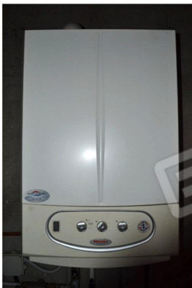
foto 17 - sub 1 (caldaia) - Il generatore di calore è un apparecchio murale da interni marca Im-mergas mod. Victrix Zeus 26, da 23.6 kW di potenza utile in riscaldamento, modulante e condensante. Incerti manutenzione periodica e denuncia al registro regionale degli impianti termici.
