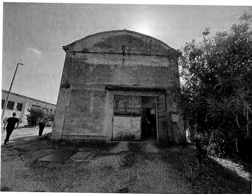
Esterni dell'unità mapp. 254 sub. 4
