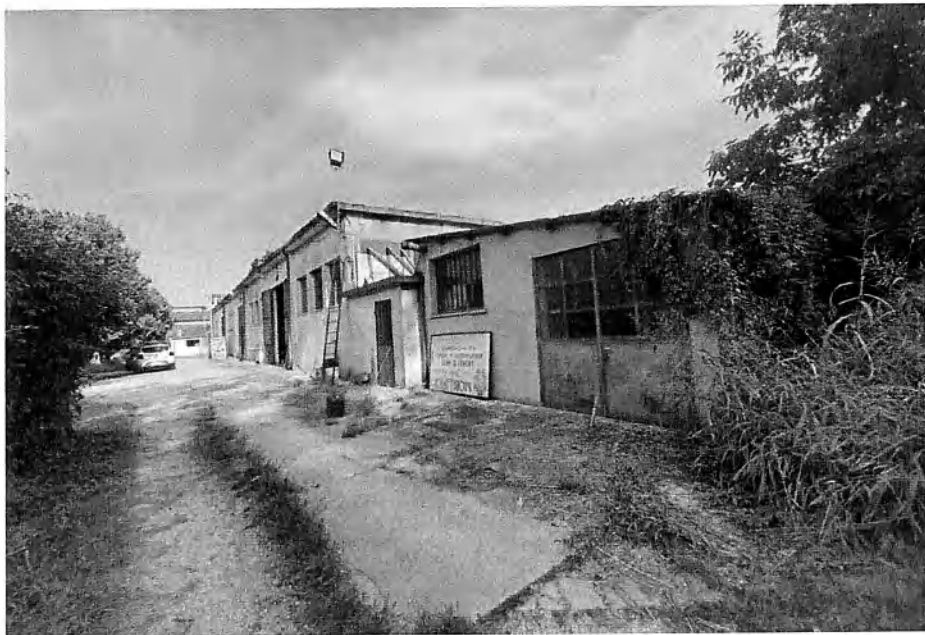
Esterni dell'unità mapp. 254 sub. 5
