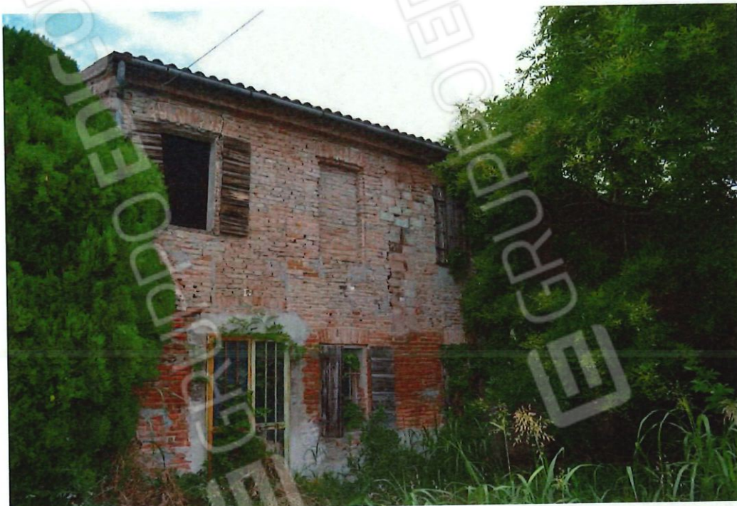
foto 1 – m.n. 316 (visto da sudovest) – Il lotto unico consta di n. 4 fabbricati e di n. 2 aree urbane, costituite da fabbricati rurali con abitazione, accessori, posto auto e corti esclusive, nonché da due relitti stradali su altrettante strisce di terreno. L'edificio di passati trascorsi abitativi – ora un rudere abbandonato da lustri, semidiroccato e inabitabile – è catastalmente suddiviso in due subalterni sia al piano terra che al primo piano. Alla fu residenza vanno attribuiti n. 16 vani al pianterreno e n. 10 al primo piano. Gli accessori sono un rustico con annesso posto auto, magazzino e fienile, una tettoia che li collega al fabbricato fronte strada e una porcaia praticamente scomparsa tra la vegetazione.
