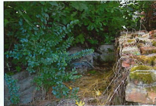
foto 10 - m.n. 316 (sub4) - Rottami edili e pacchi di nylon a ridosso confine di proprietà.
