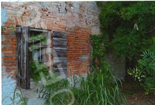
foto 5 - m.n. 316 (sub3) - La tessitura muraria è ricca di inclusioni e di discontinuità materiali.
