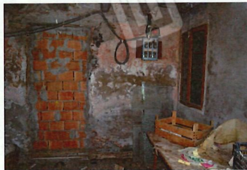
foto 15 - sub 1 (magazzino) – La porta murata è rivolta verso il locale di cui alla precedente foto n. 13. La separazione fisica tra i due ambienti corrisponde a quanto rappresentato sia catastalmente che amministrativamente. Funzionalità elettriche da verificare.
