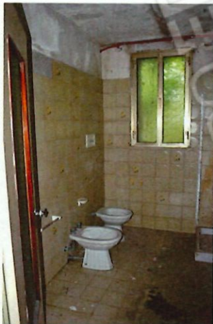
foto 6 - sub 3 (WC) - Nel bagno si trovano lavandino a colonna (in foto non visibile), piatto doccia, tazza e bidet. I rivestimenti sono ceramici smaltati, sui muri fino a 2,2m.
