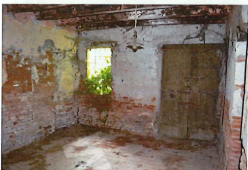
foto 10 - sub 1 ("ripostiglio") - Anche questo è un rustico assimilabile a cantina, con porta a due battenti in legno massiccio e finestra a sola inferriata. L'accesso dà sulla corte esterna esclusiva del sub 1, su via Fontana. Il pavimento è in battuto di cemento. Intonaci scrostati e carpenterie lignee fatiscenti.
