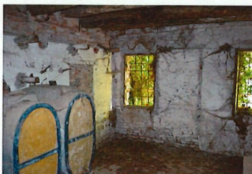
foto 9 - sub 1 ("ripostiglio") - Malgrado la destinazione d'uso catastale, si tratta di una cantina tenuta al rustico, con tanto di damigiane spillabili a basamento fisso. Finestre con la sola inferriata.
