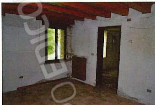
foto 12 - sub 3 (soggiorno) – Si tratta di uno dei vani ridotti meno peggio, con tinte perlopiù integre salvo qualche sbollamento, pavimenti in cotto, infissi in legno tenero e ordito in non pessimo stato di fatto.
