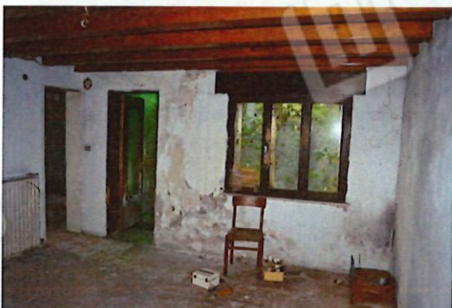
foto 8 - sub 3 ("cucina") - Indicato al catasto come cucina, questo è in realtà un soggiorno. L'unica dotazione tecnologica visibile sulle pareti è un calorifero in ghisa. Impalcati di piano completamente lignei.
