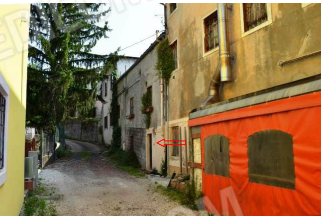
foto 12 - Scorcio ovest della parte centrale col civ. 77
