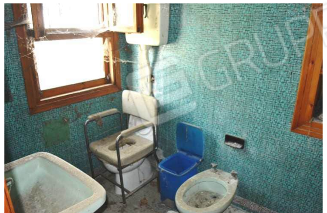
foto 25 - Scorcio interno del bagno dell'abitazione
