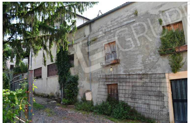
foto 13 - Scorcio ovest della parte nord e centrale
