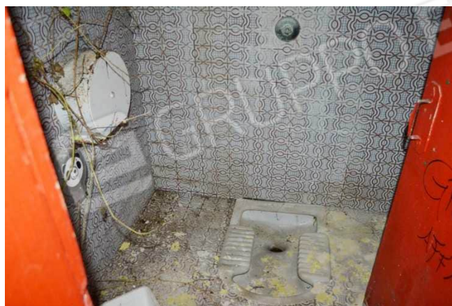
foto 18 - Locale servizi visto dall'ingresso
