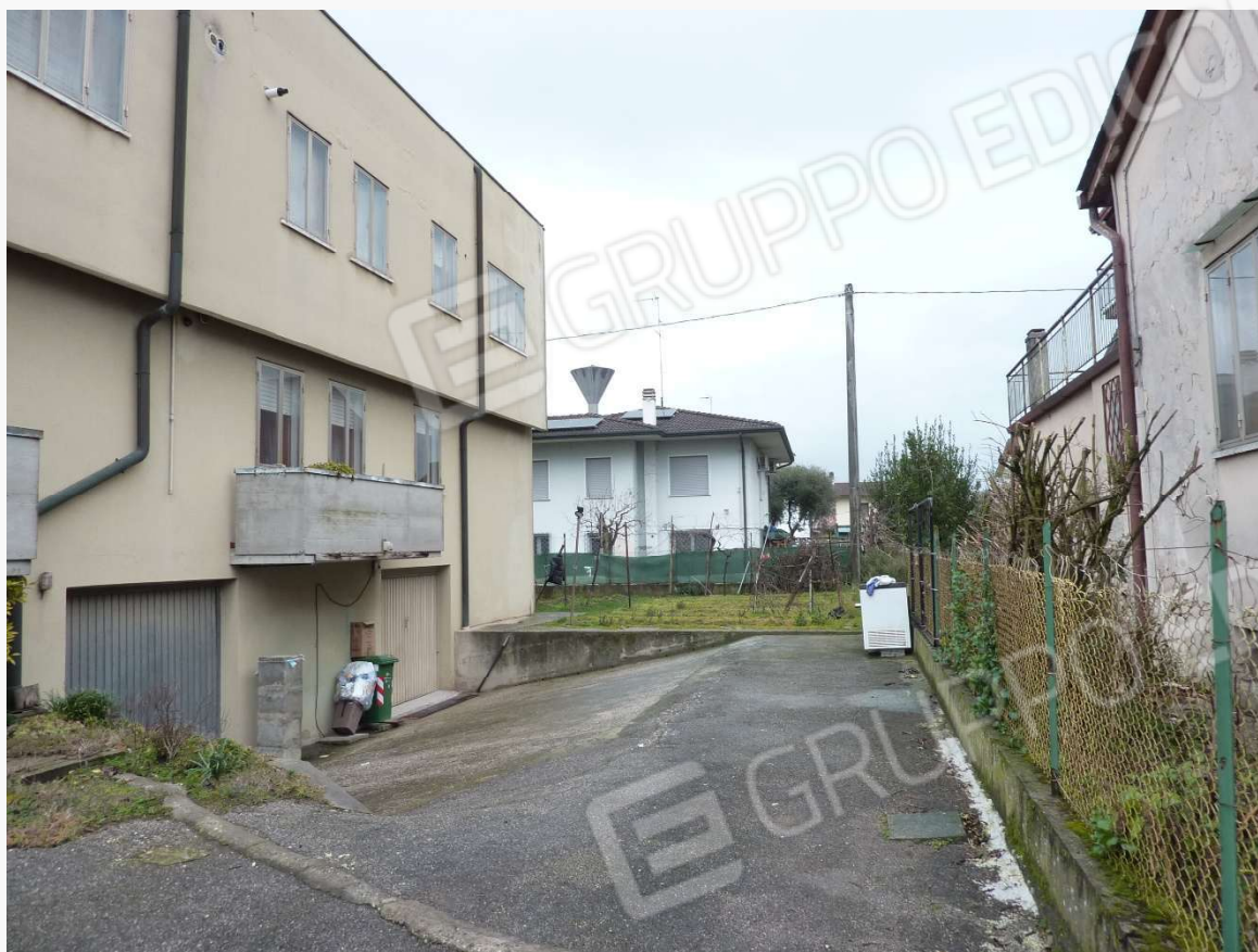
FOTO 5 _ VISTA LATERALE DEL FABBRICATO DALL'AREA PERTINENZIALE ESTERNA – PROSPETTO SUD
