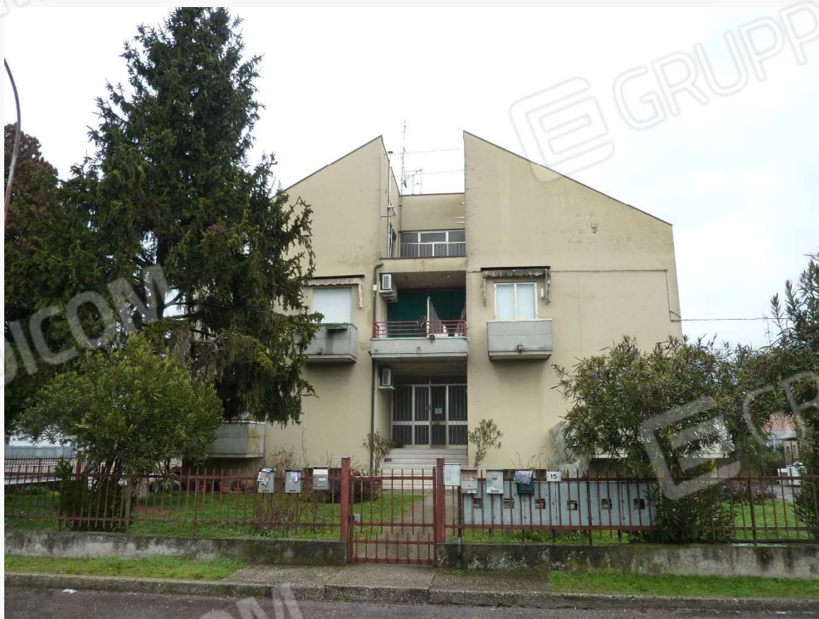
FOTO 12 _ VISTA DEL COMPLESSO IMMOBILIARE DA VIA BERSAI – PROSPETTO OVEST
