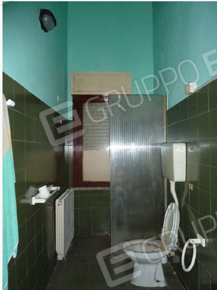
FOTO 9 _ VISTA INTERNA – BAGNO APPARTAMENTO SUB 6 – PIANO SECONDO
