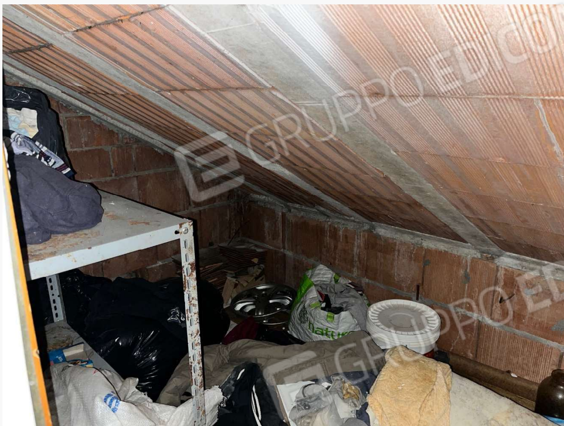
FOTO 11 _ VISTA INTERNA – RIPOSTIGLIO APPARTAMENTO SUB 6 – PIANO SECONDO
