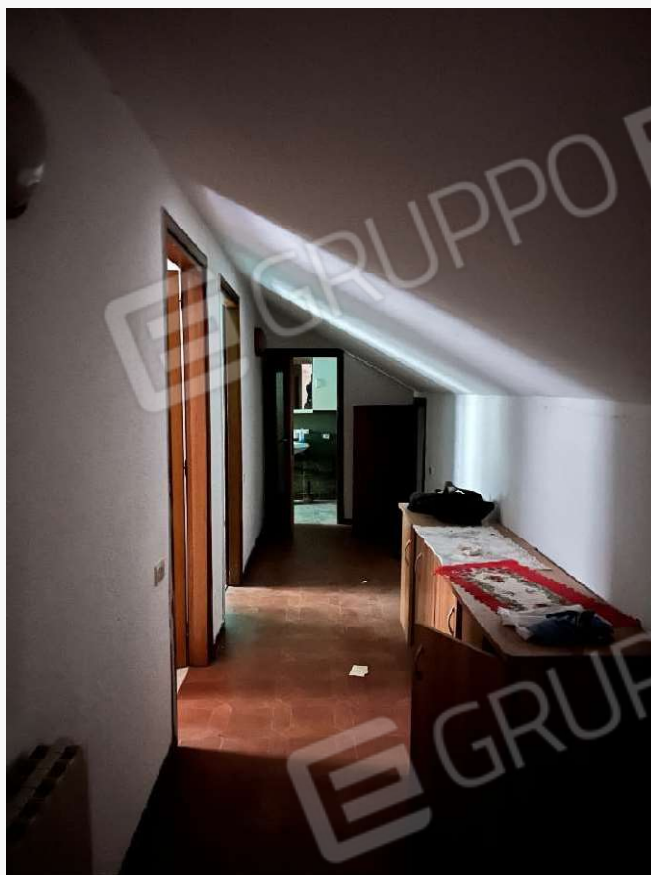
FOTO 5 _ VISTA INTERNA – CORRIDOIO SUB 6 – PIANO SECONDO
