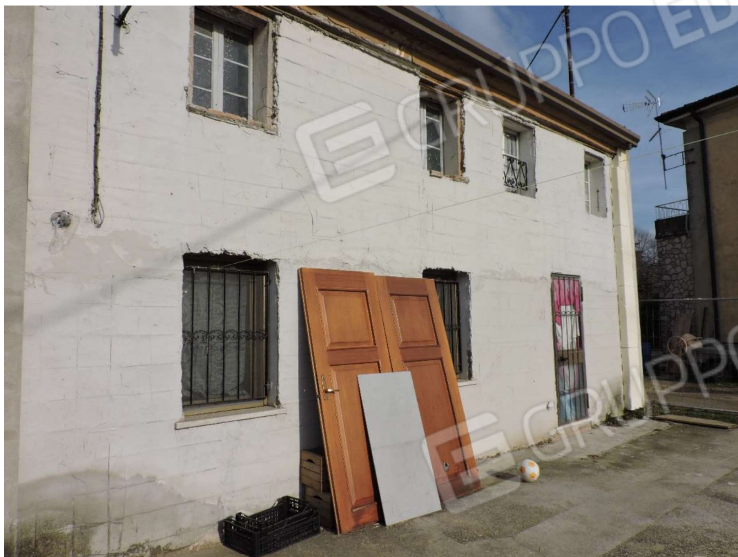
Foto 3 Fronte posteriore fabbricato abitativo - data scatto 27.01.2026
