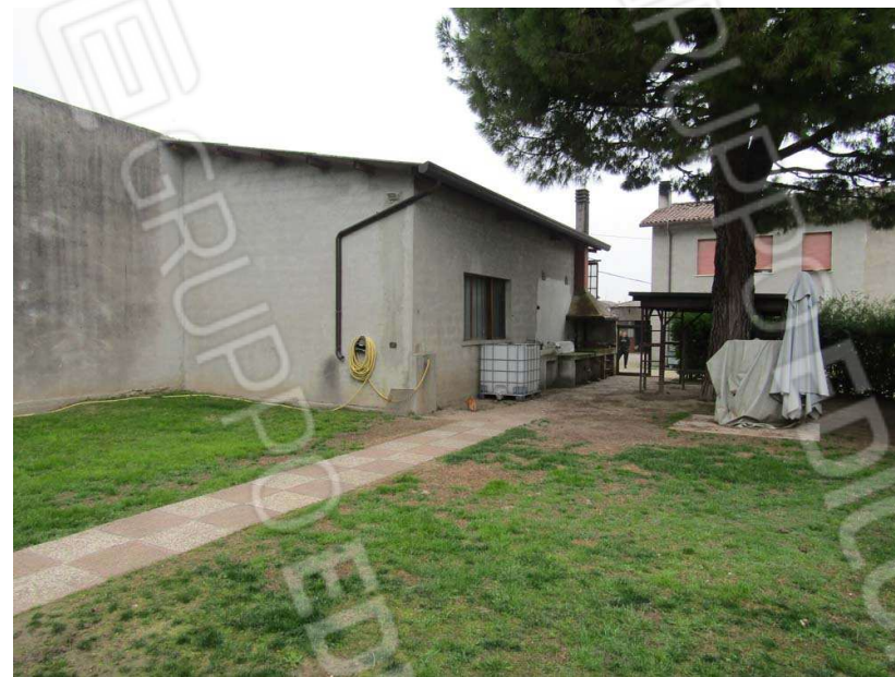
Foto 4: vista del corpo del laboratorio a sud
