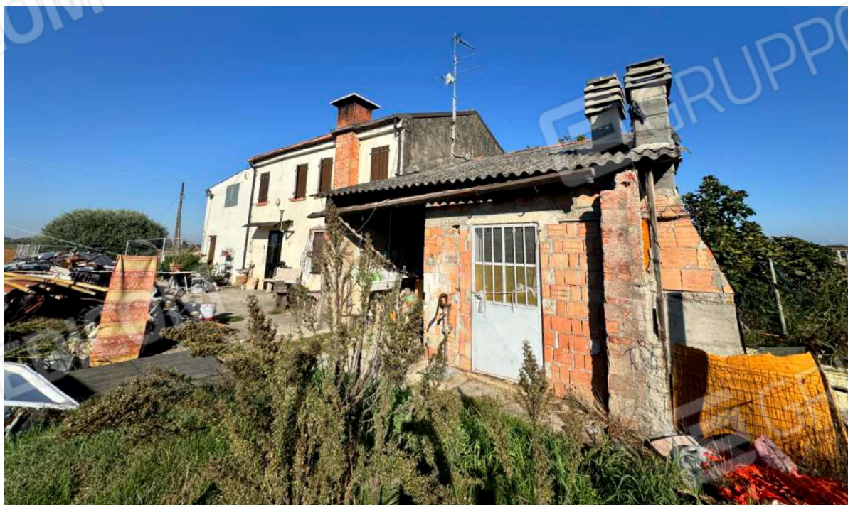
FOTO 4 - Fronte sud-ovest 1.a
