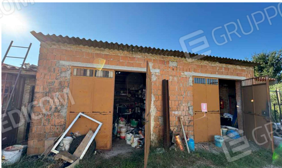
FOTO 6 - Fronte nord 1.b
