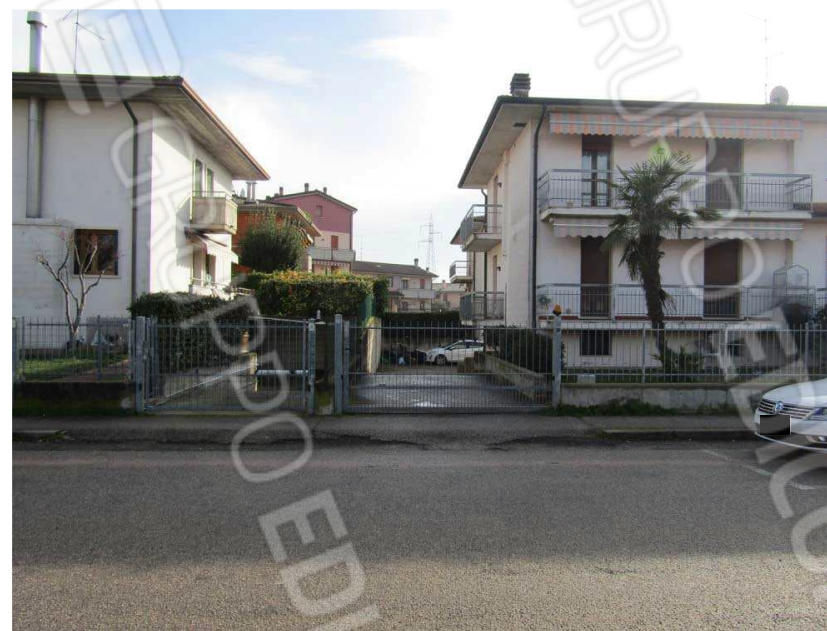
Foto 12: vista dell'accesso carraio da Via Udine 16
