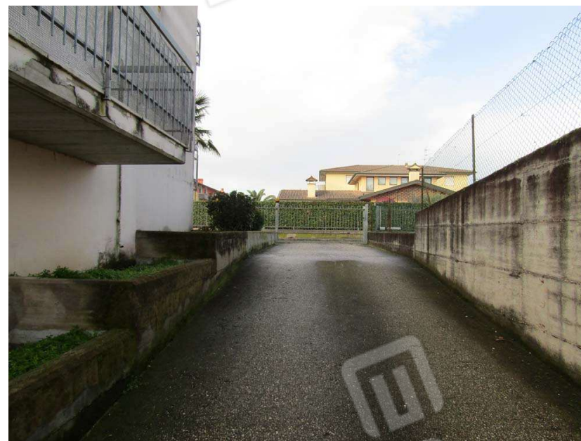
Foto 10: vista della rampa di accesso (partic. 912 sub 12)
