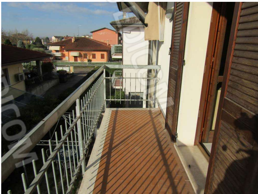
Foto 25: vista del balcone della camera matrimoniale al primo piano
