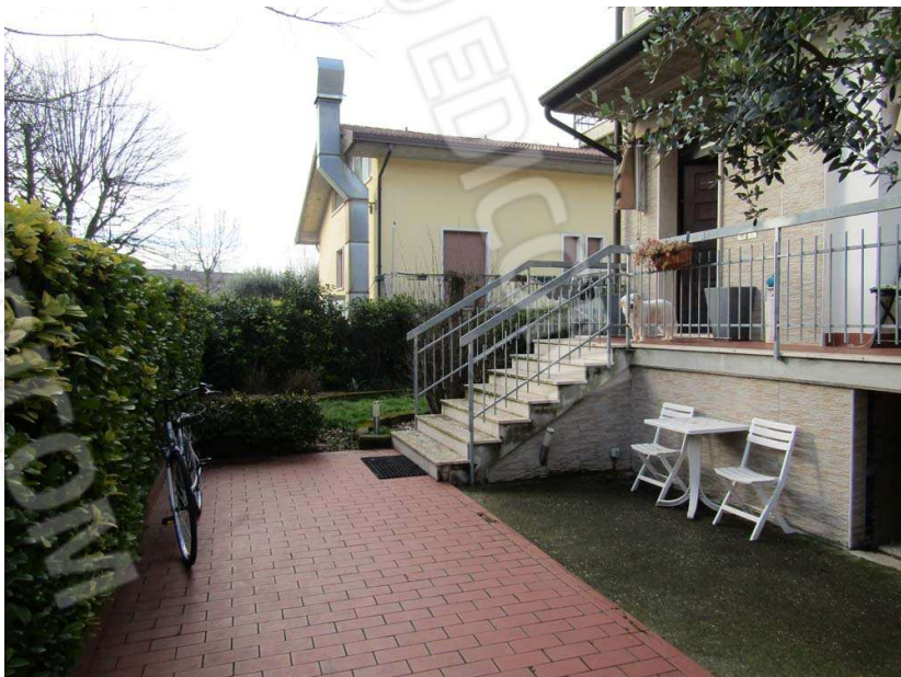
Foto 5: scorcio sulla scala di accesso ad est
