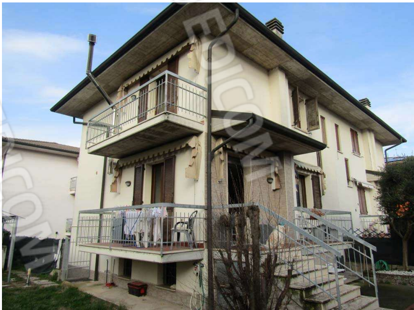
Foto 1: vista d'insieme del fabbricato da sud-est
