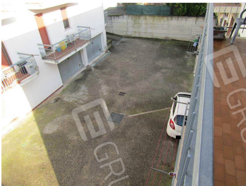
Foto 11: vista della corsia carraia comune al piano seminterrato
