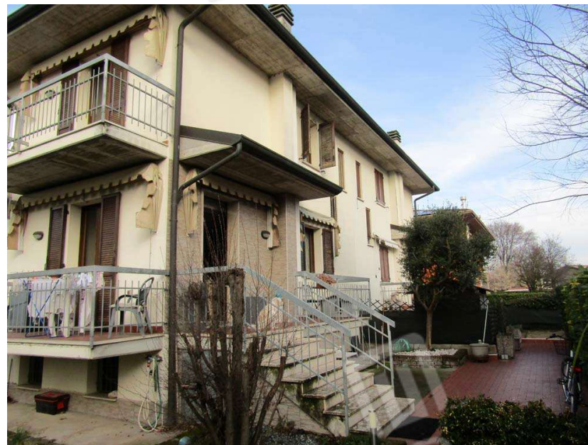
Foto 2: vista d'insieme del prospetto est
