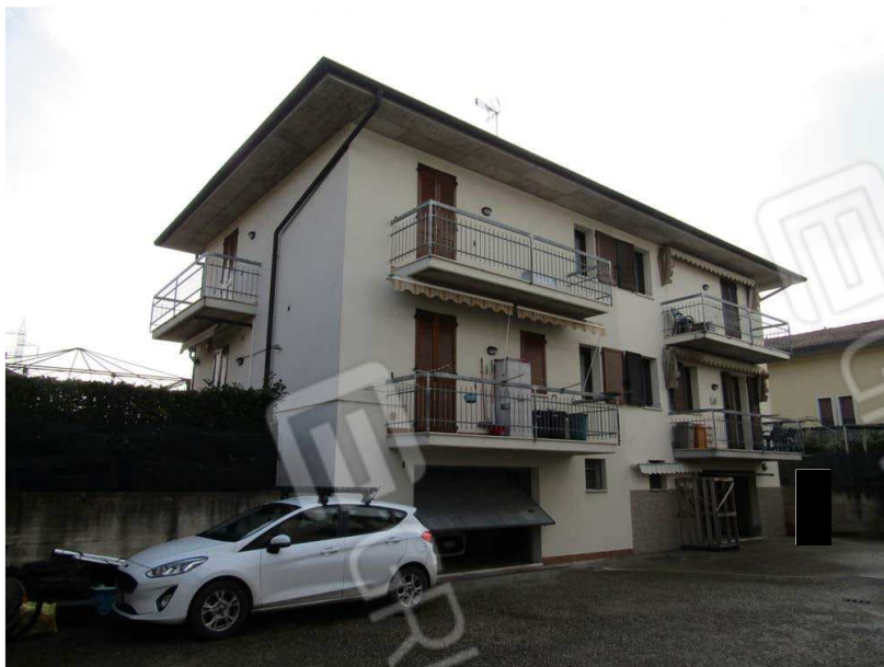
Foto 7: vista dell'edificio dalla corte interna partic. 911 sub 5
