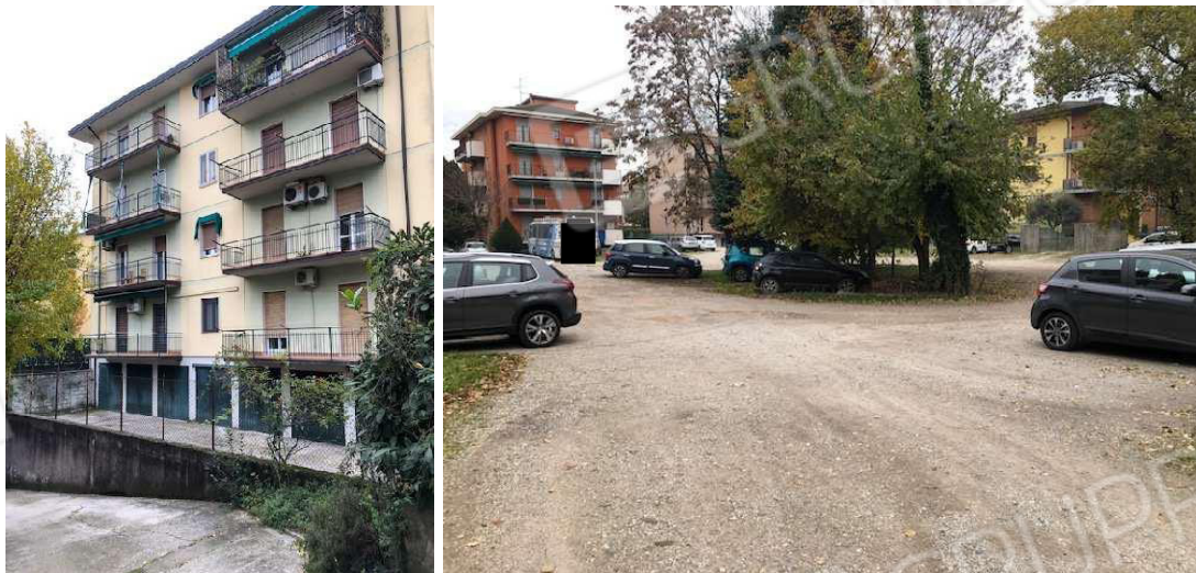
Retro edificio con autorimesse
