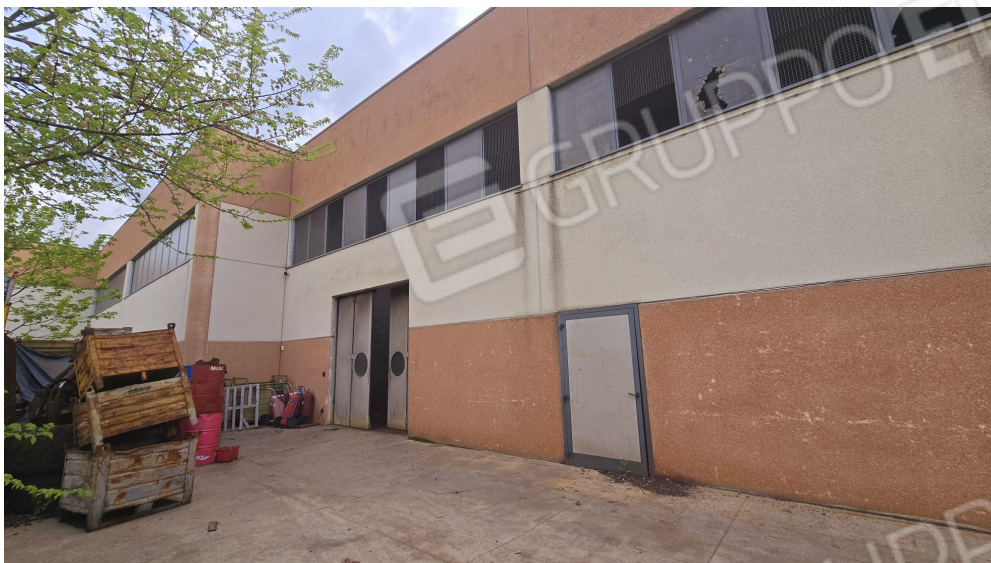
Foto 13 – Vista prospetto ovest e area esterna sul retro
