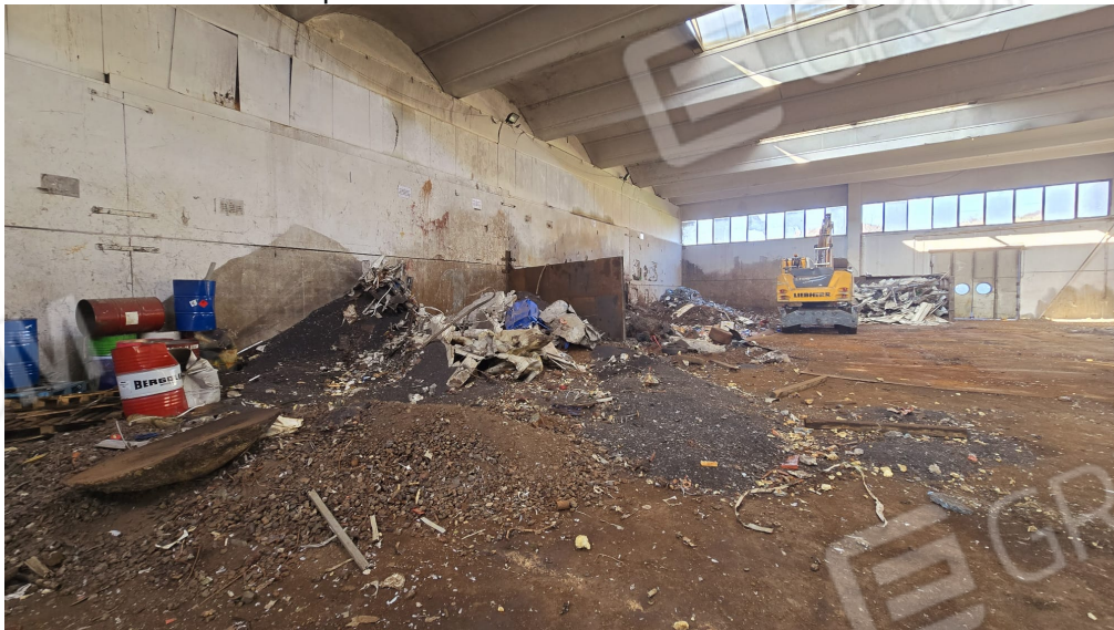
Foto 8 – Vista interna capannone
