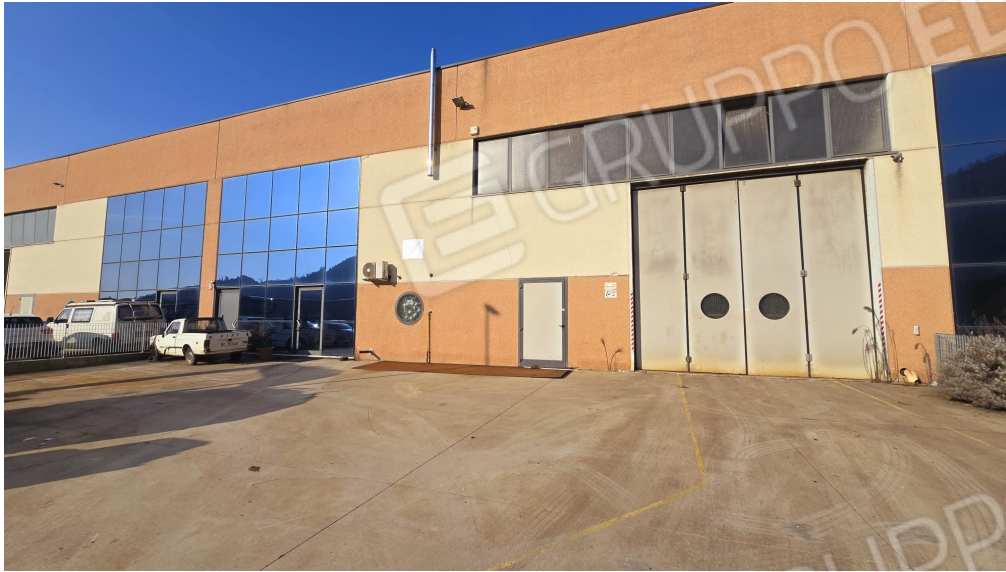
Foto 1 – Vista dal cortile interno
