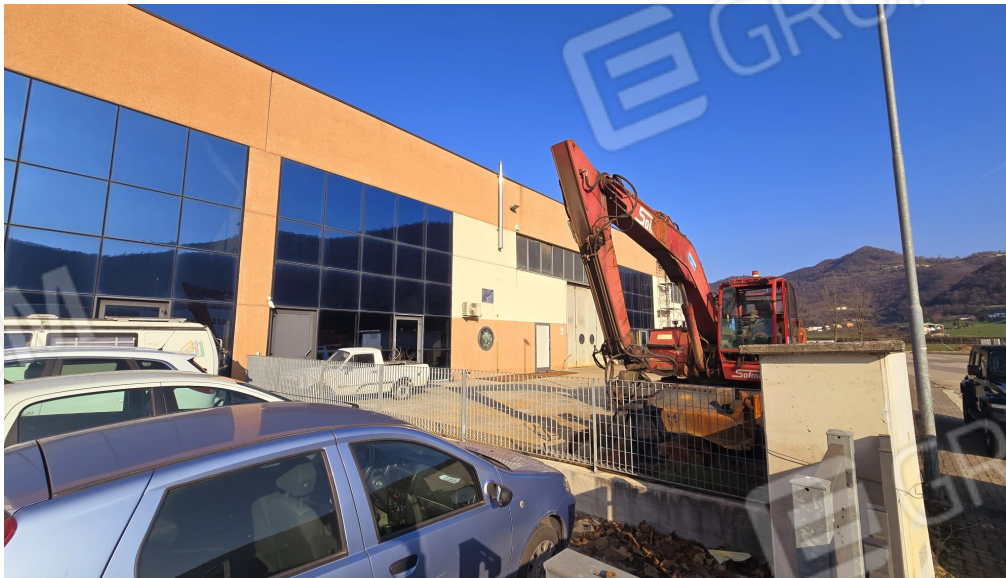
Foto 2 – Vista da Strada Provinciale XII della Priabona
