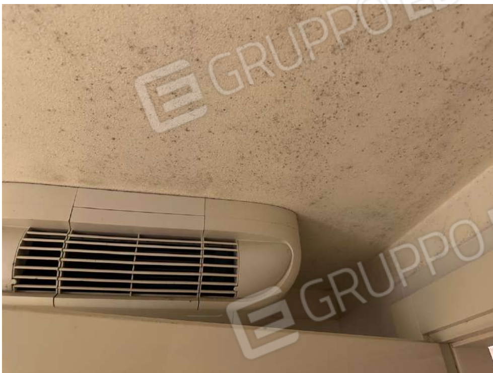
Dettaglio soffitto cantina.
