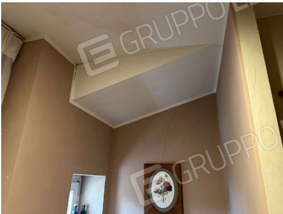
Dettaglio bagno piano primo.
