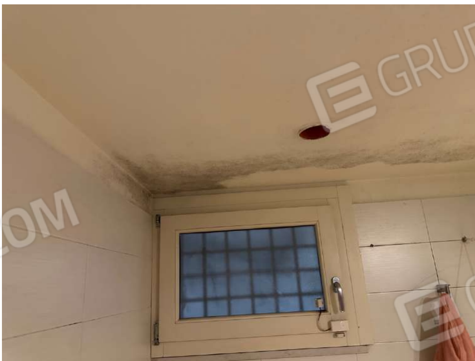
Dettaglio soffitto cantina.
