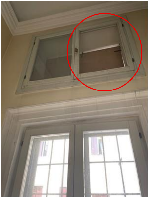
Foto 1: finestrella alta – rottura vetro
