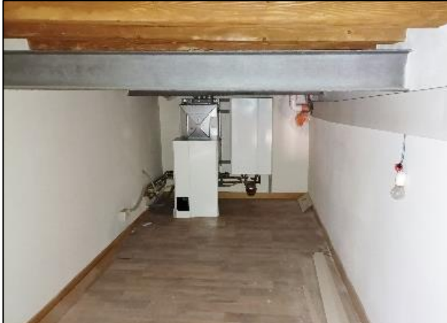
locale tecnico con centrale termica
