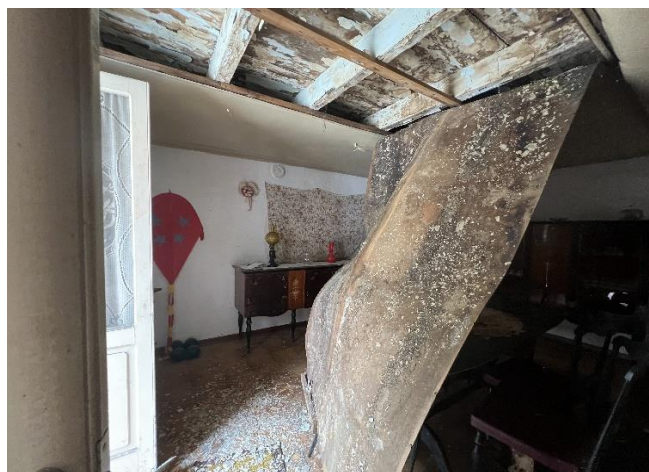
Vista del controsoffitto del solaio in legno crollato
