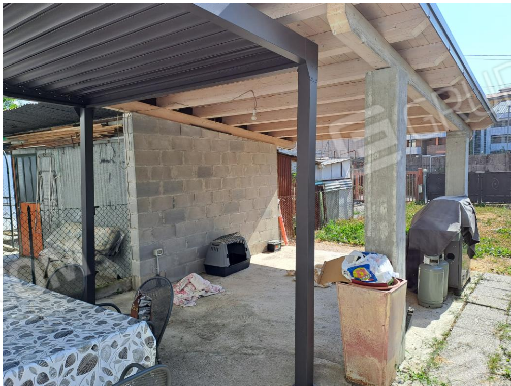
Vista della tettoia e dell'area scoperta
