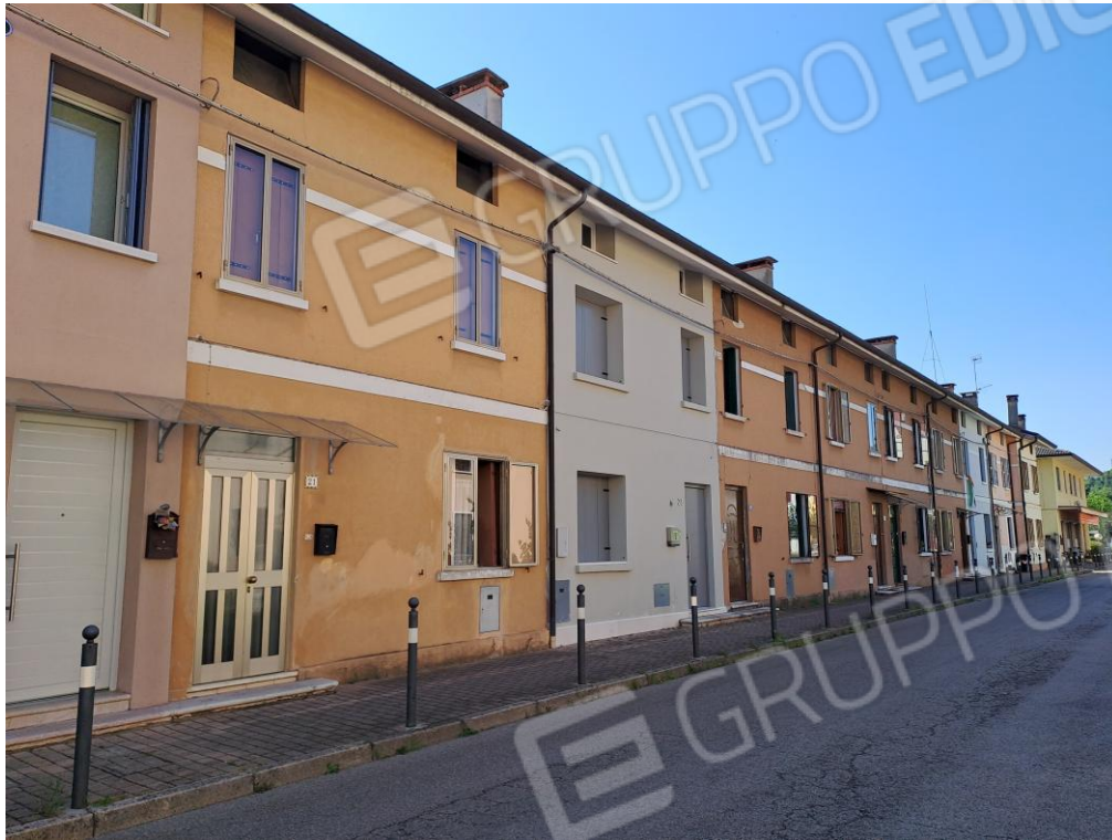
Vista generale da Nord-Ovest
