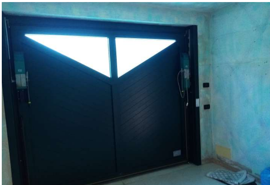
Figura 16 vista interna autorimessa
