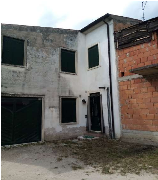
Figura 7 Facciata interna su corte comune
