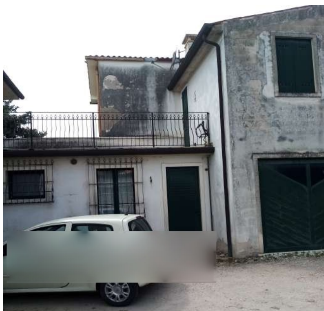
Figura 15 Facciata interna su corte comune
