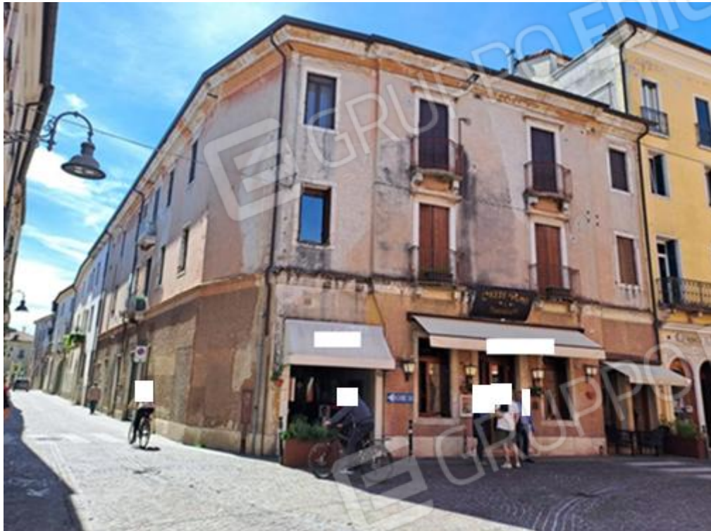
Vista generale da Nord
