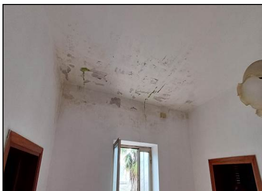
Infiltrazioni solaio ingresso piano primo
