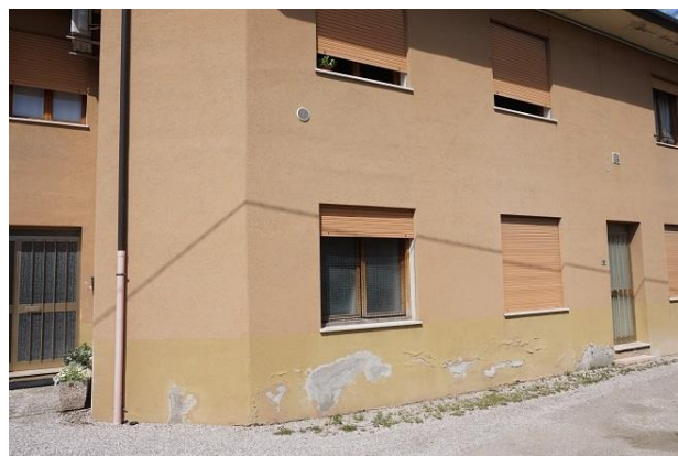
Particolare scrostatura parete fronte sud/ovest
