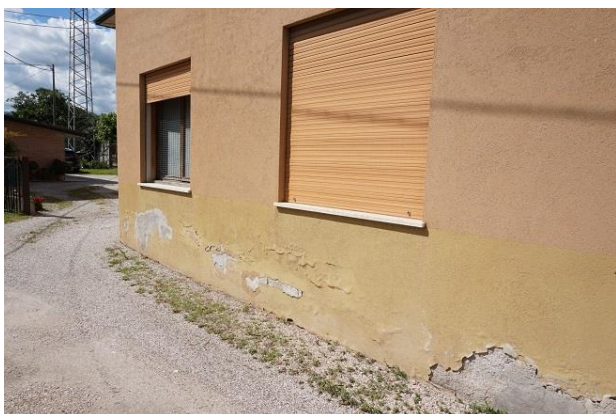
Particolare scrostatura parete fronte sud/ovest
