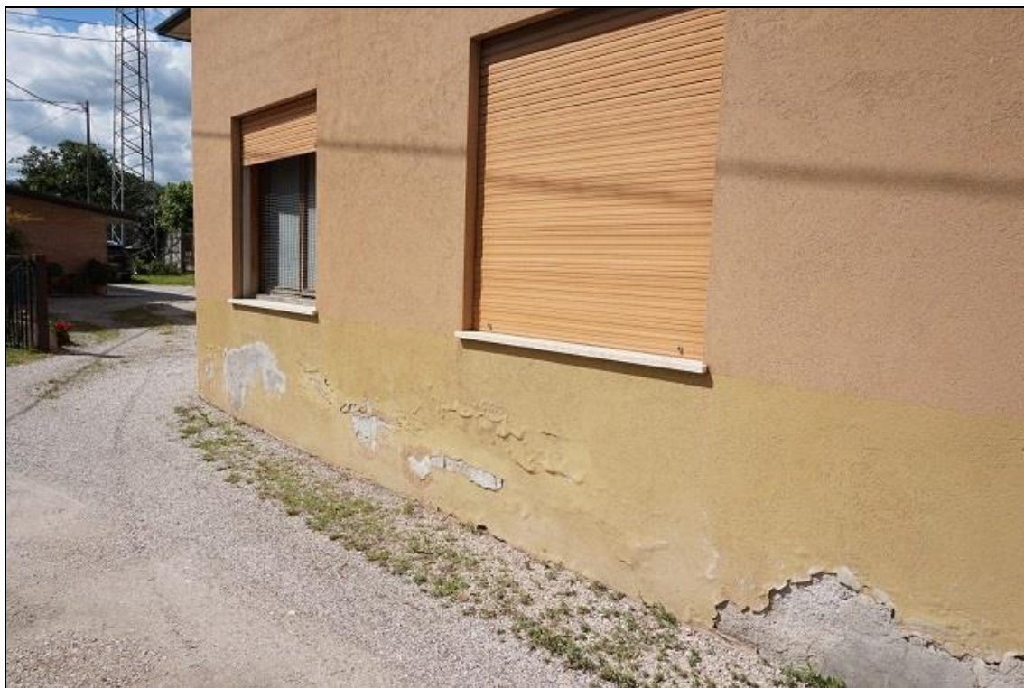
FOTO 5 – Dettaglio scrostatura parete fronte sud/ovest
