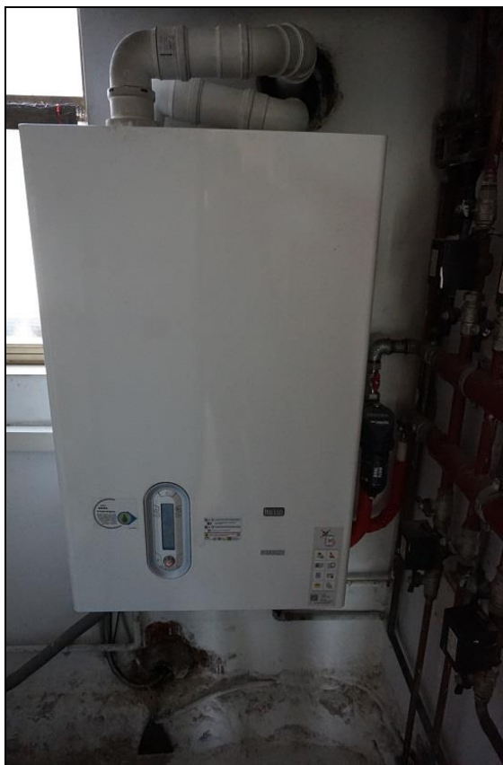
FOTO 15 – Piano Terra – Caldaia su centrale termica
