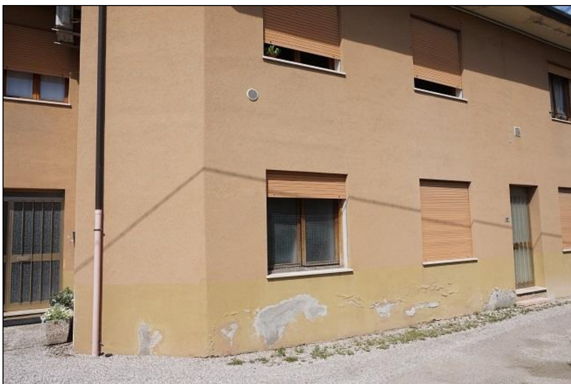
FOTO 6 – Particolare scrostatura parete fronte sud/ovest
