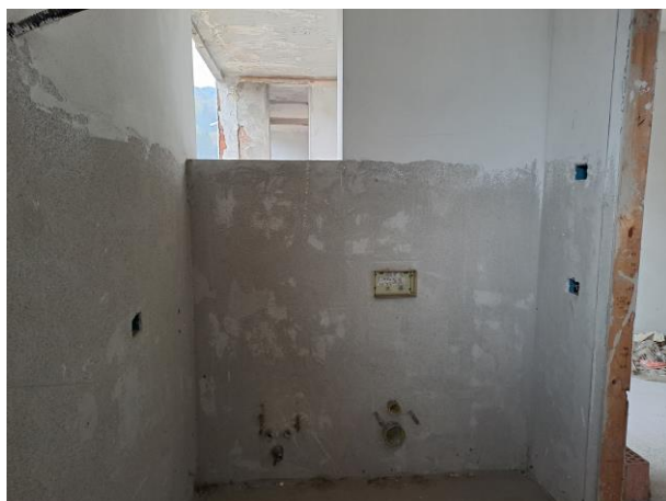
Vista del servizio igienico
