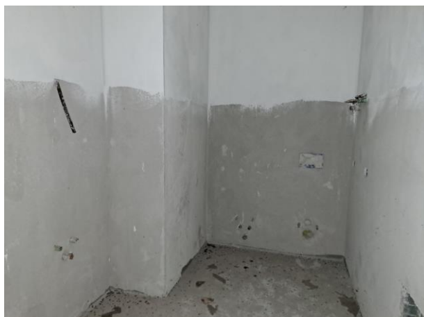
Vista del servizio igienico
