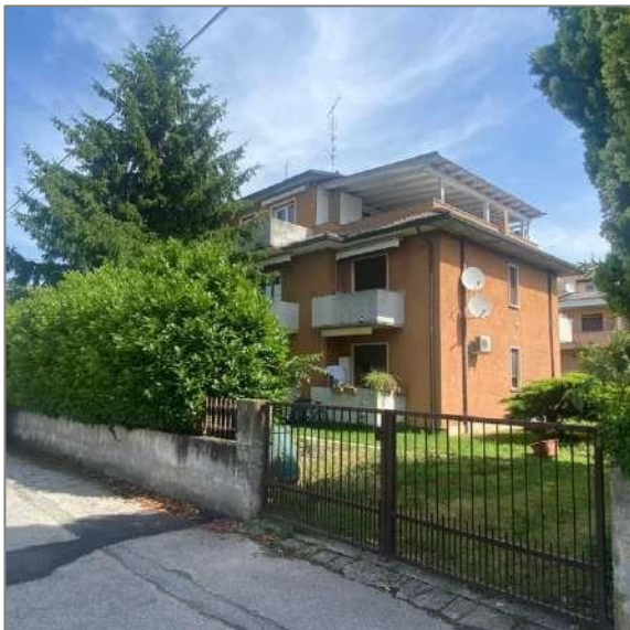
L'accesso carraio e il fronte Est
