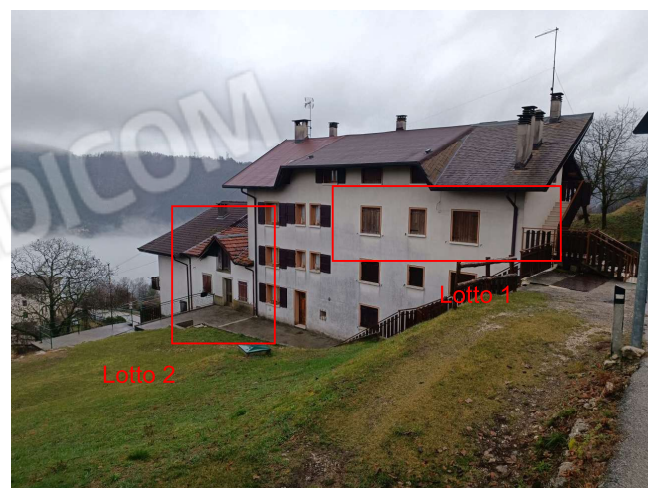
Vista retro da via Fosse di Sopra
