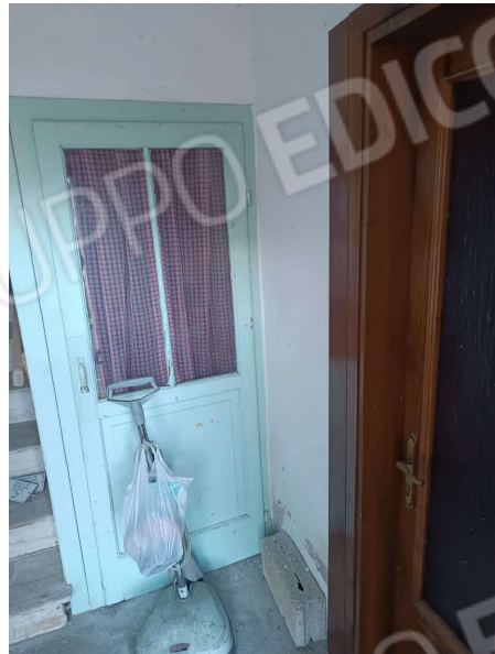
Vista interna "Lotto 2" – Scala comune
