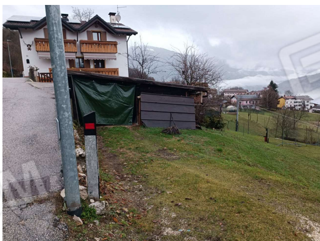
Vista annesso lato nord su m.n°434 "Lotto 1"
