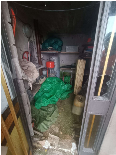
Vista interna cantina "Lotto 1"
