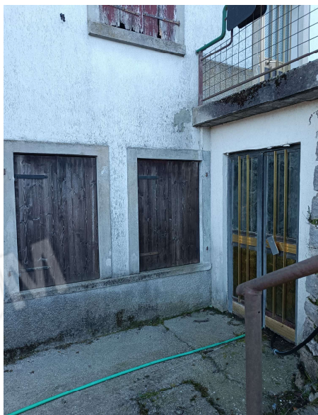
Vista ingresso lato nord abitazione "Lotto 2"
