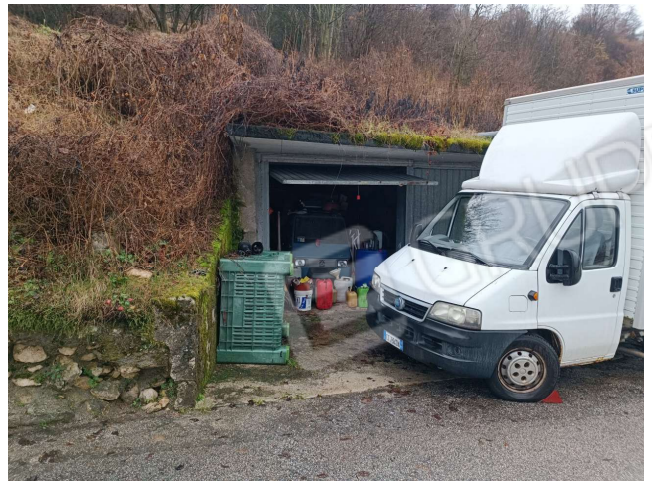
Vista esterna "Lotto 1"
