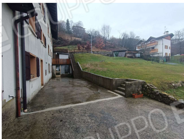
Vista terreni lato nord "Lotto 1"
