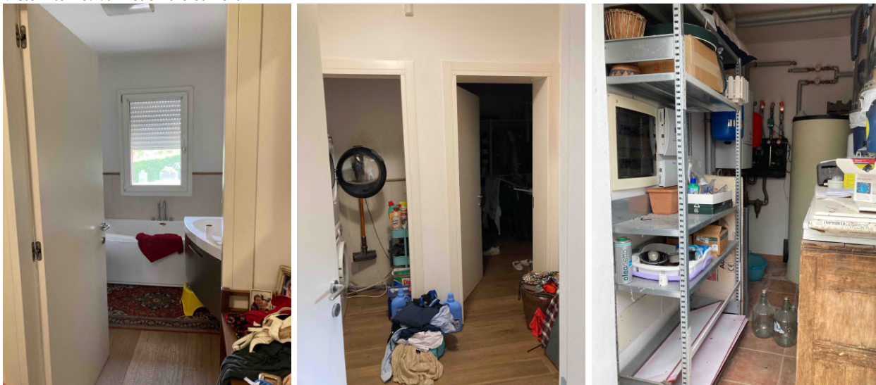
Viste interne: bagno, disimpegno e sub 7 b.c.n.c. (centrale termica) comune ai sub. 4, 5 e 6
