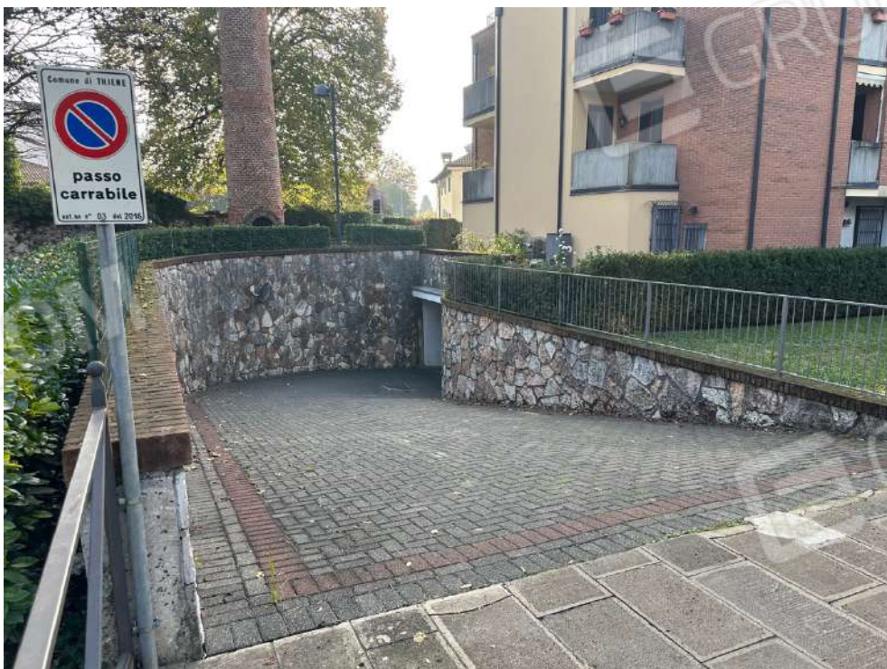
Rampa di accesso al garage.
