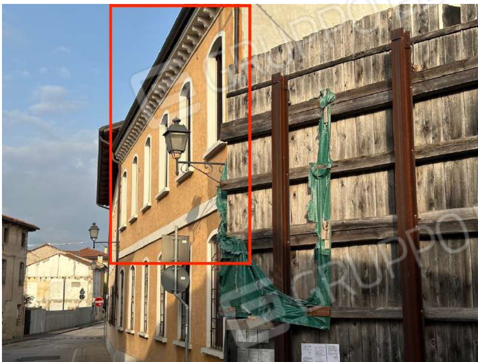
Prospetto sud-ovest (verso strada pubblica).
