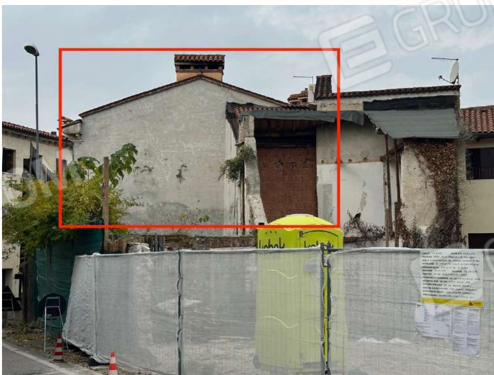
Prospetto sud-est (verso altra proprietà).
