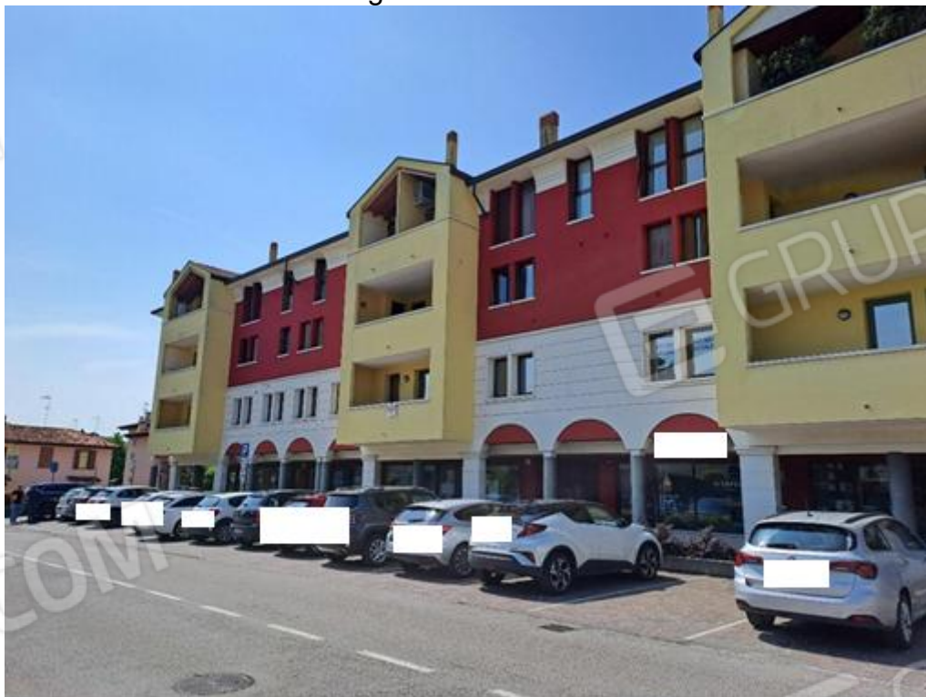
Vista generale da Nord-Ovest
