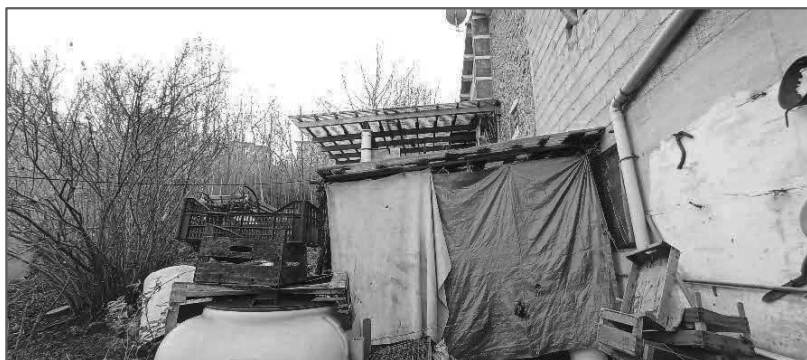
Baraccamenti lato est
