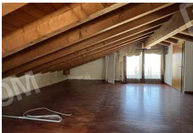
Vista del sottotetto
