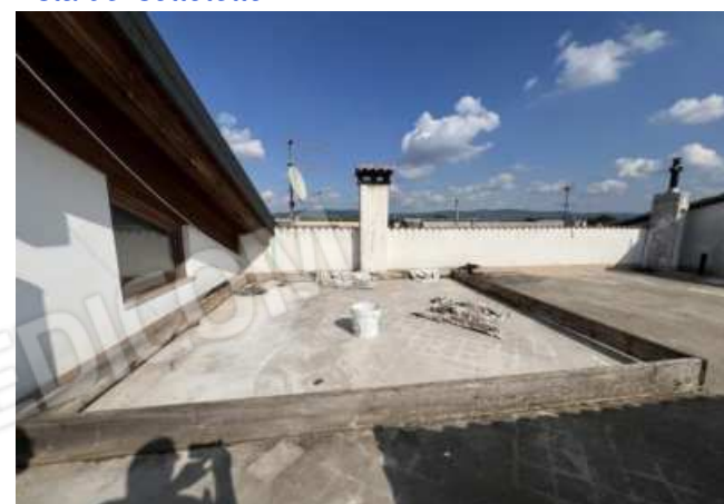
Vista della terrazza di copertura
