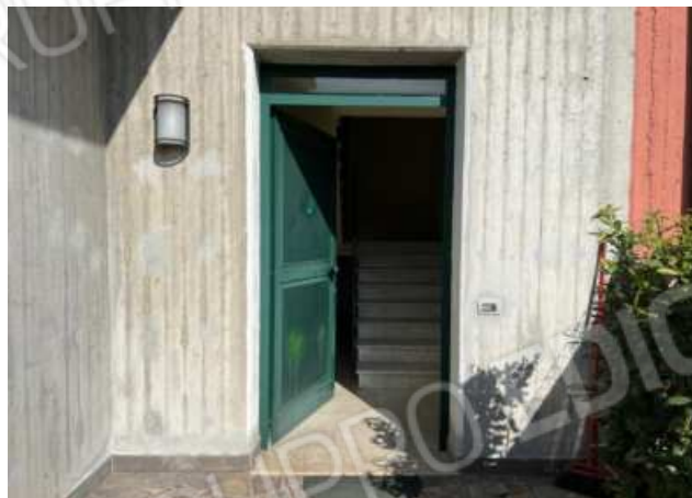
Vista dell'ingresso al vano scala dell'appartamento
