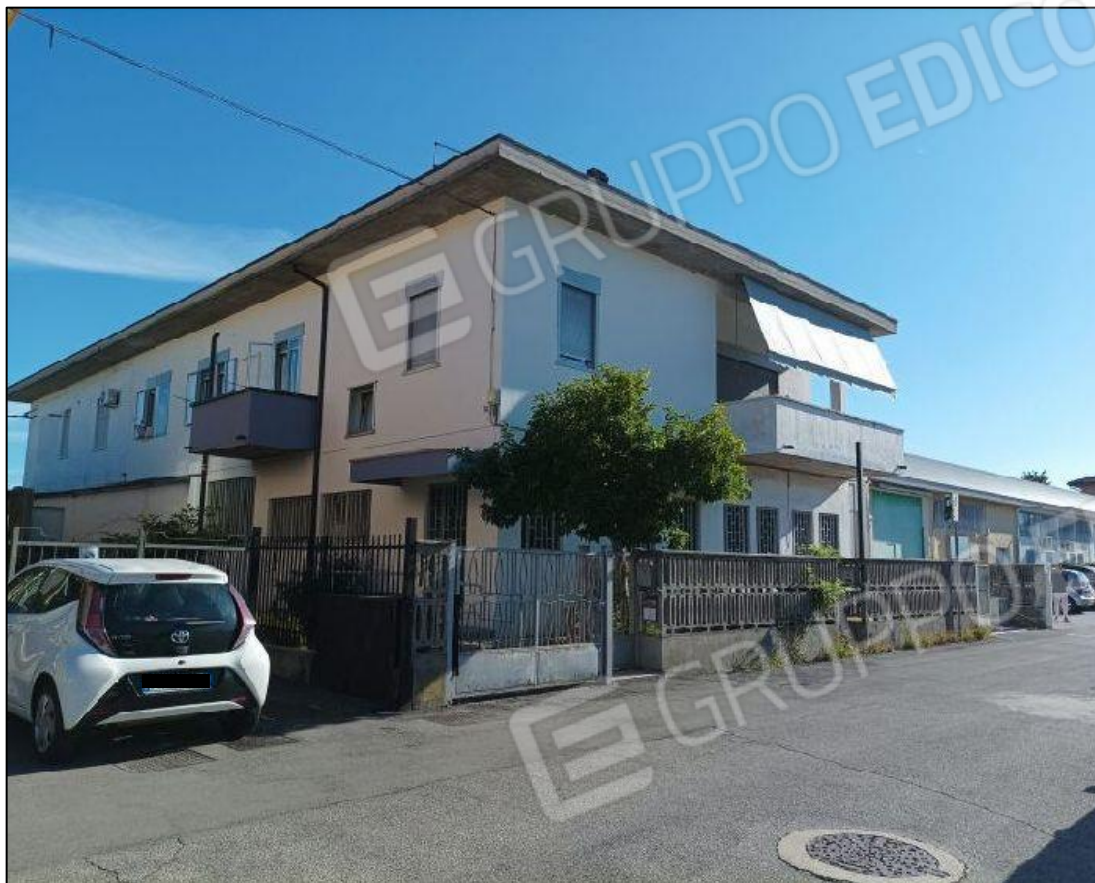
Edificio su via Odorico da Pordenone
