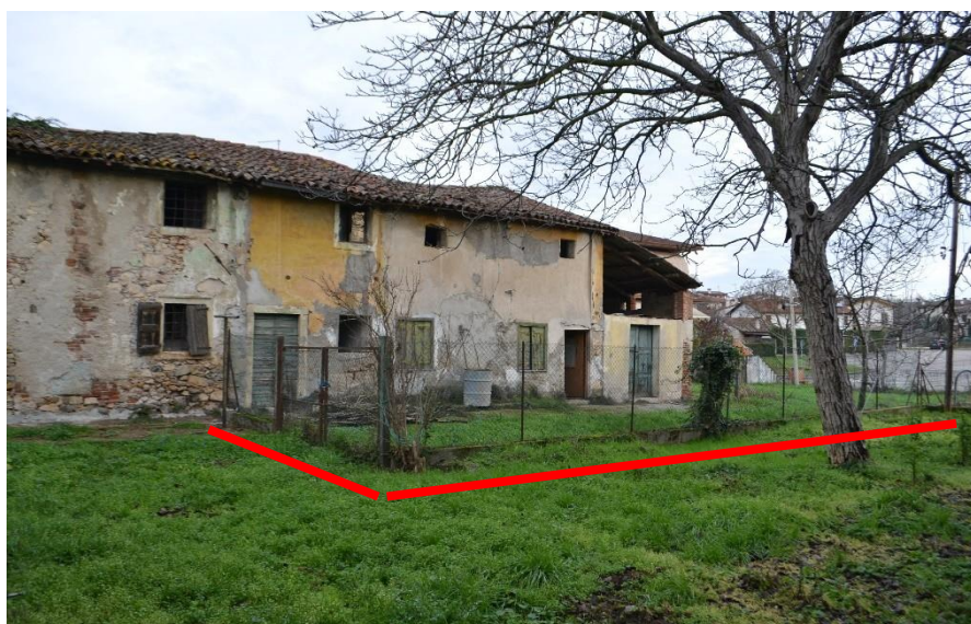
Figura 7 – DETTAGLIO RECINZIONE E CANCELLO CON ACCESSO DA VIA G. MARCHI;
