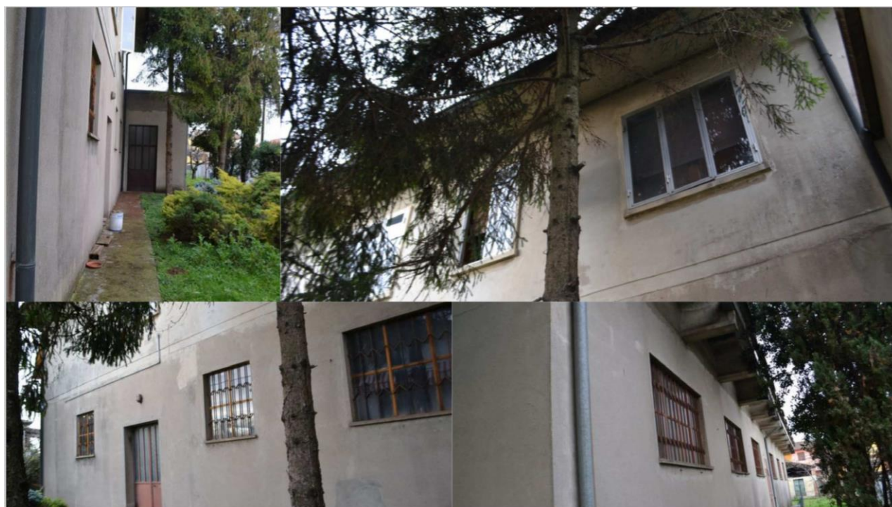
Fig.89-90-91-92-PROSPETTO EST-RETRO EDIFICIO ARTIGIANALE
