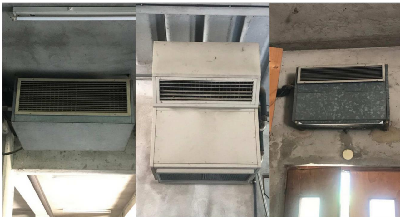
Fig.82-83-84-Interno laboratori- Ventilconvettori presenti in ognuno dei tre laboratori;
