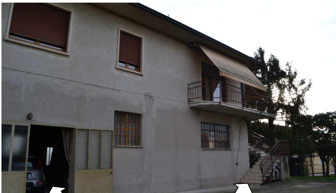
Fig.19- Ingresso al fabbricato artigianale
