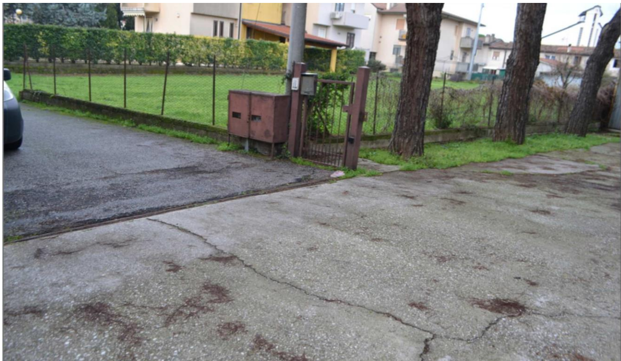
Fig.68- Ingresso pedonale carrabile al fabbricato artigianale;
