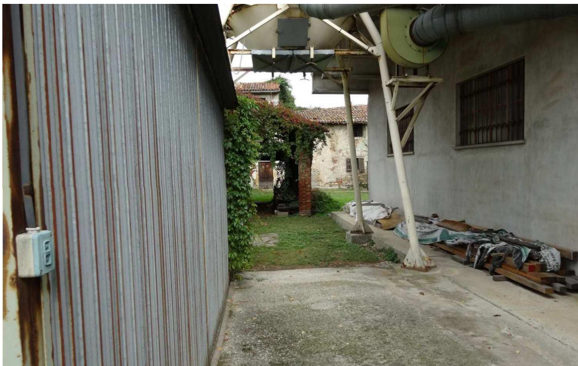
Figure 11 – 12- IMMOBILE PREFABBRICATO IN LAMIERA DA DEMOLIRE
