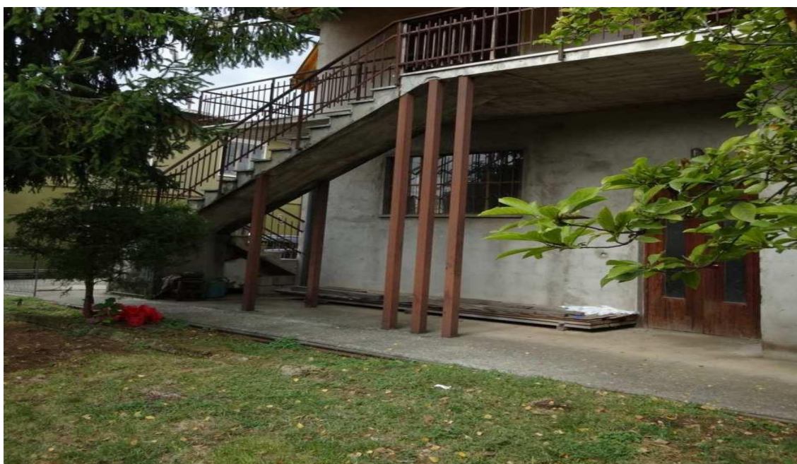
Figure 17- Ingresso-ballatoio e zona sottoscala-portico
