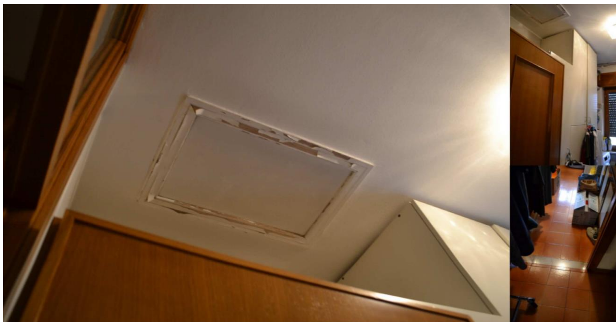
Figure 60-61-VANO LAVANDERIA DOTATO DI BOTOLA DI ISPEZIONE SUL SOTTOTETTO
