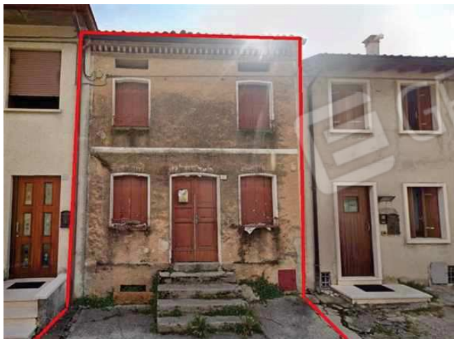
Vista della facciata dalla via Mazzacavallo
