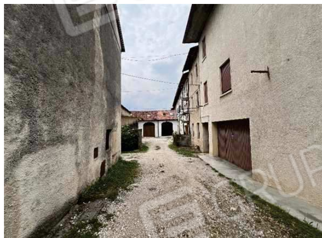
Vista dell'ingresso dalla corte comune sul retro
