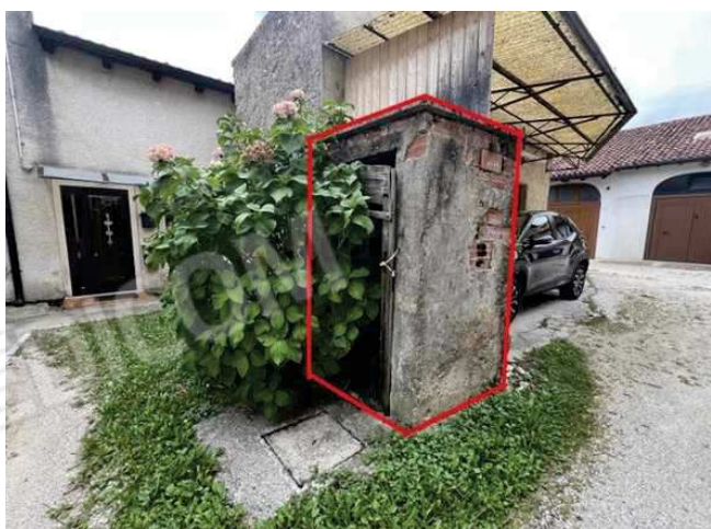
Vista del manufatto (wc) sulla corte esclusiva
