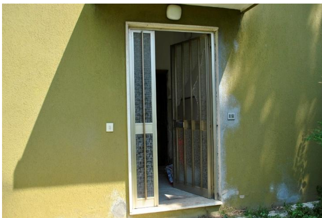
Foto 9 – accesso vano scala comune
