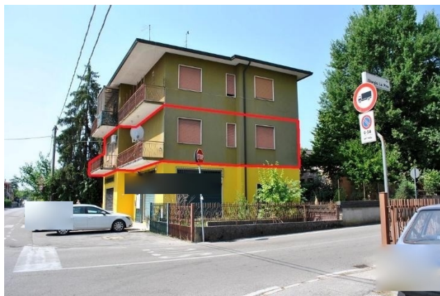
Foto 3 – vista da nord – da via La Pira
