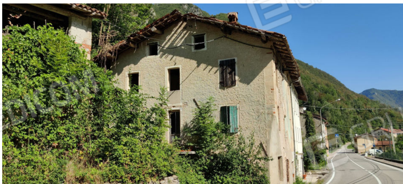
Foto n° 04 – Vista dell'abitazione da Sud
