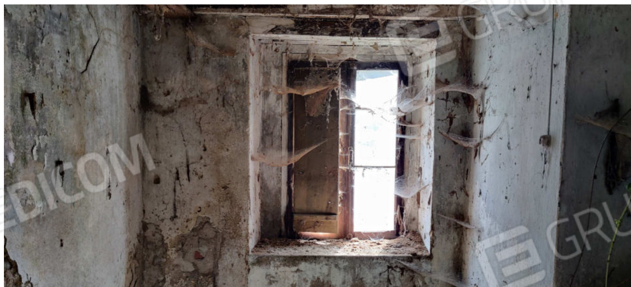
Foto n° 10 – Vista di uno degli ambienti del piano terra
