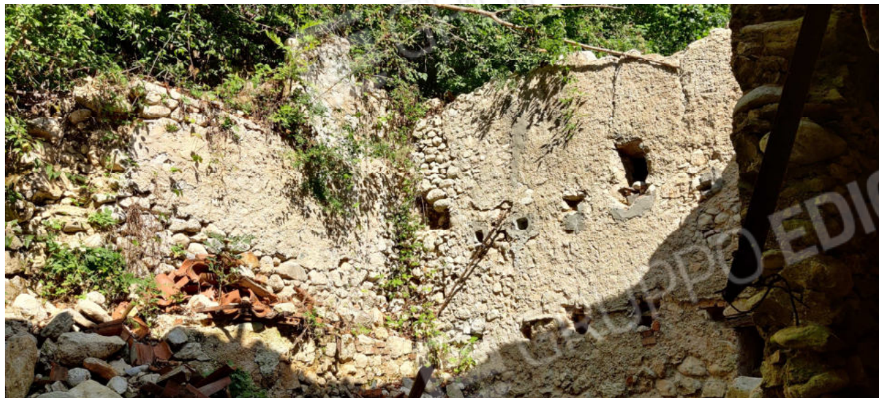
Foto n° 12 – Vista del deposito
