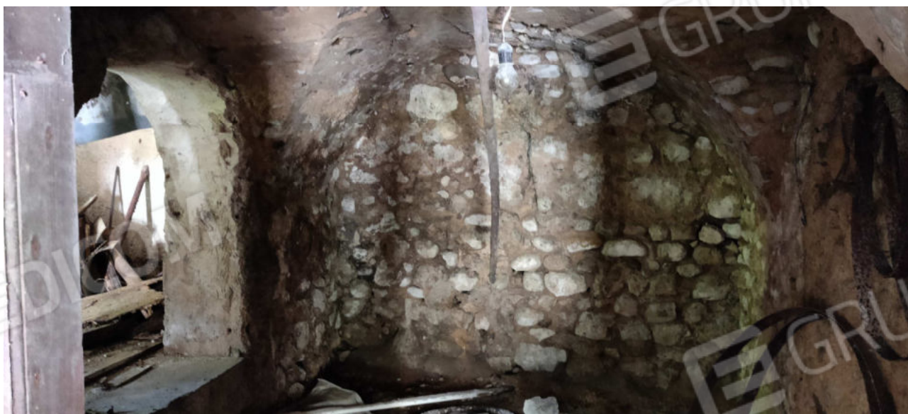
Foto n° 08 – Vista di uno degli ambienti del piano terra
