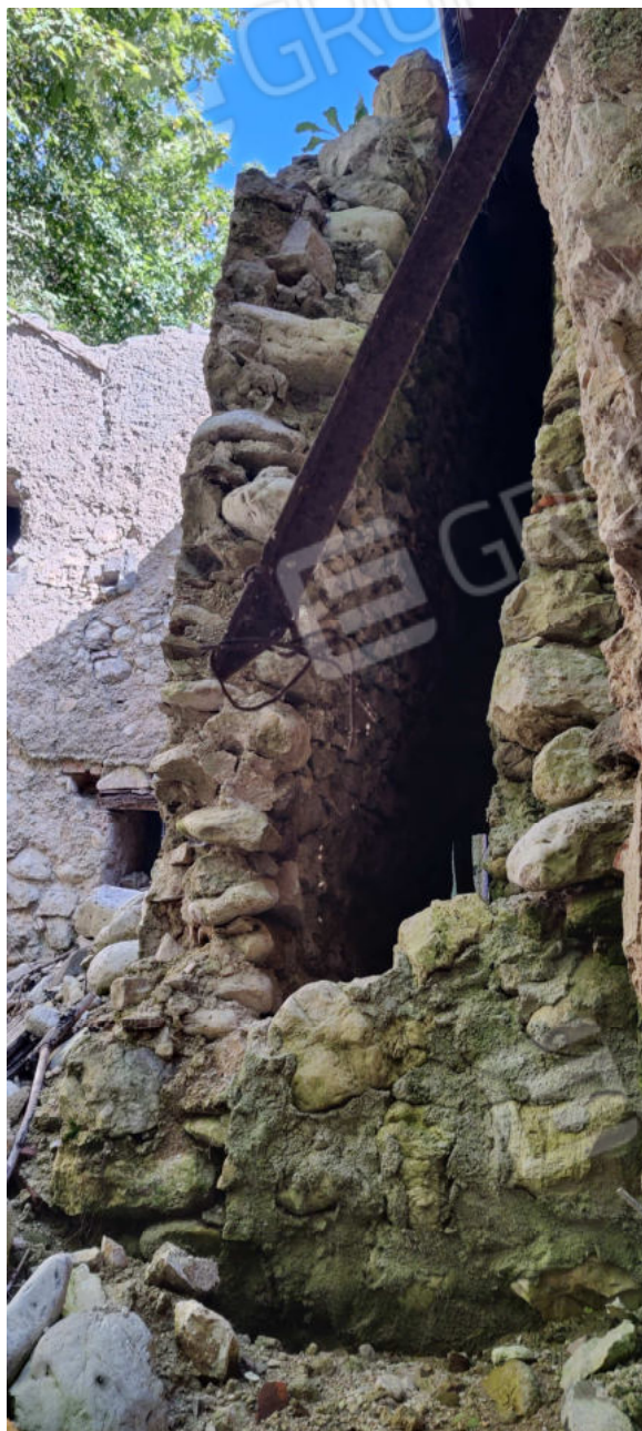
Foto n° 11 – Vista del deposito
