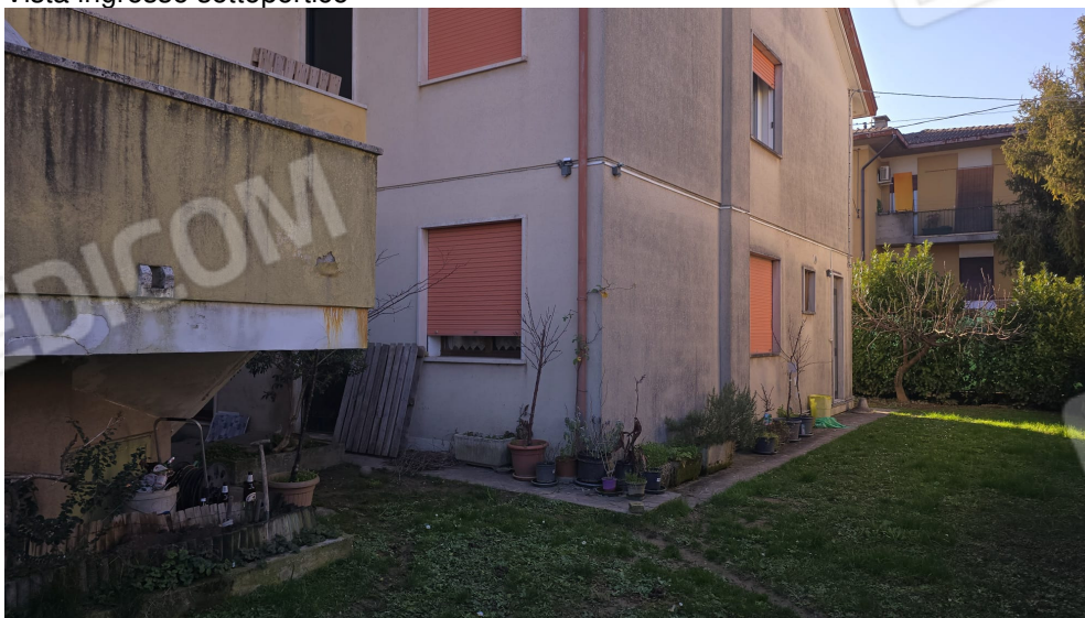
Vista esterna angolo nord-est
