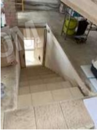
Foto 16 Scala vs. soffitta
