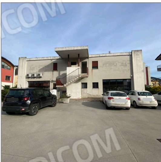
FOTO 4 - Vista dalla corte comune - fronte Ovest
