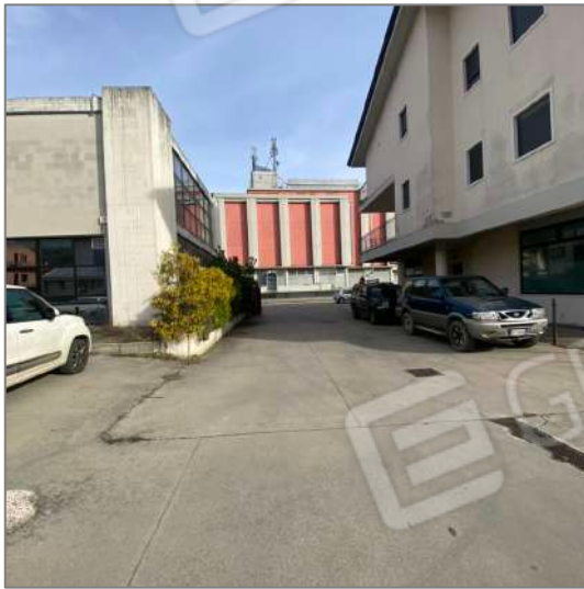
FOTO 6 - L'accesso carroio e pedonale da Via Dal Maso
