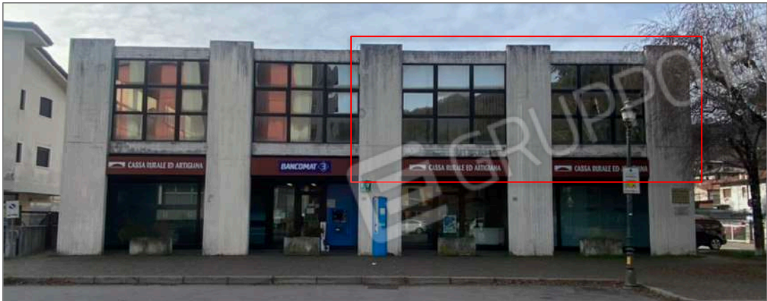
FOTO 8 - L'unità al piano primo subalterno 23
