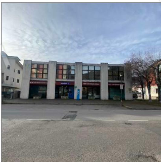
FOTO 2 - Vista da Via Dal Maso - fronte Est
