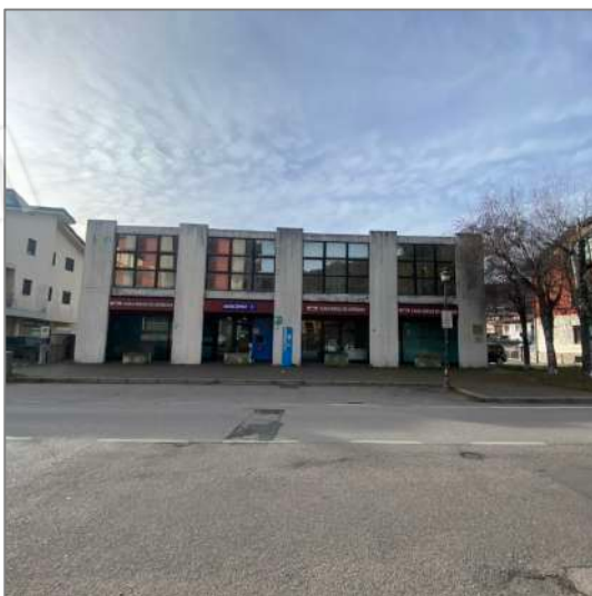
FOTO 2 - Vista da Via Dal Maso - fronte Est
