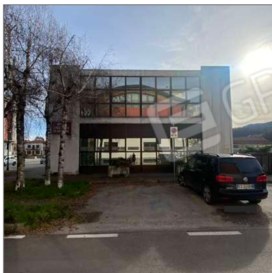
FOTO 5 - Vista da Via Trento - fronte Nord
