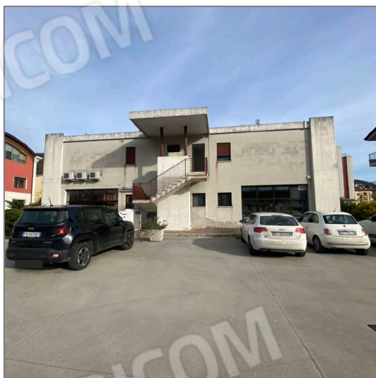
FOTO 4 - Vista dalla corte comune - fronte Ovest
