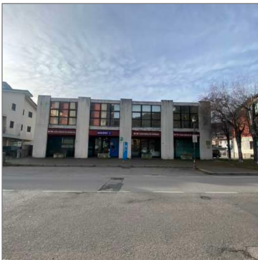
Vista da Via Dal Maso - fronte Est
