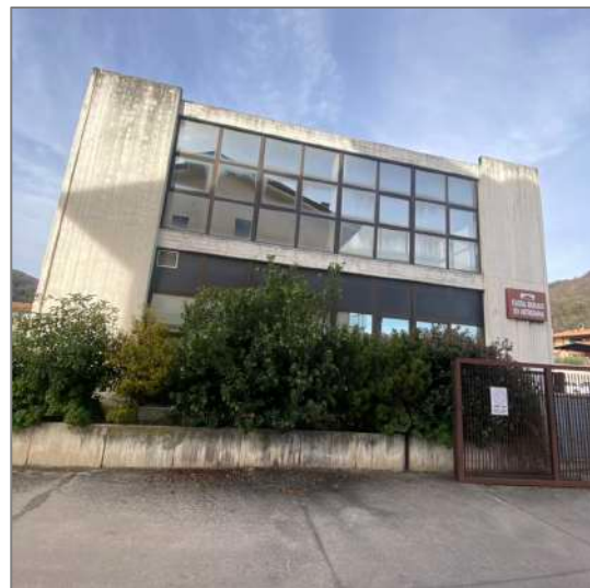
Vista dall'accesso carraio/pedonale - fronte Sud
