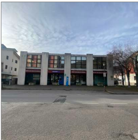
Vista da Via Dal Maso - fronte Est
