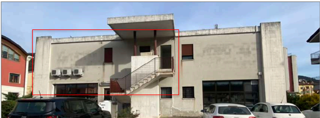
Scala di accesso al piano primo
