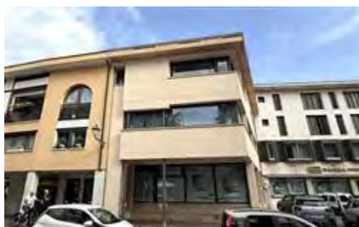
Vista da Corso Mazzini
