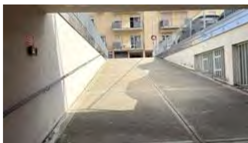
Ingresso carraio garage
