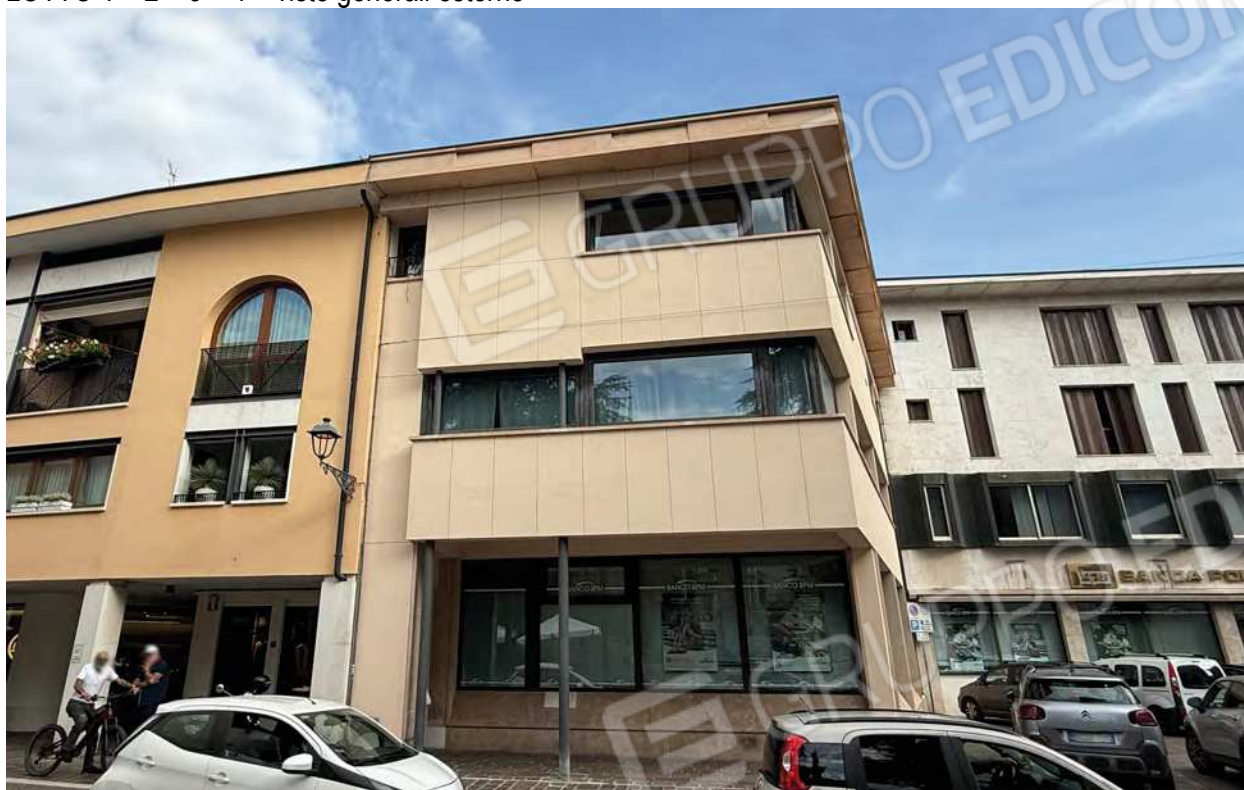
Foto A – Vista esterna da Corso Mazzini
