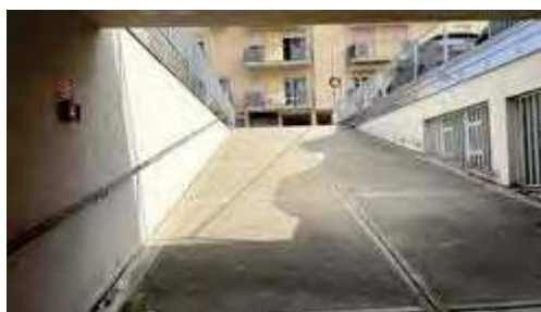
Ingresso carraio garage
