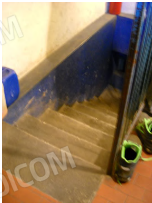
Scala d'accesso alla ex centrale termica comune
