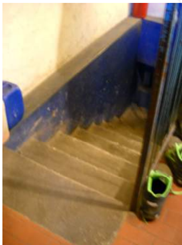
Scala d'accesso al piano interrato
