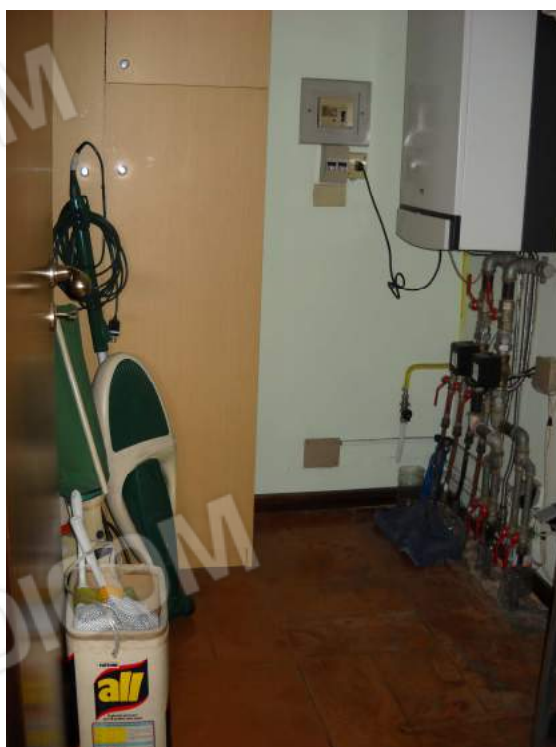
Locale ripostiglio e centrale termica
