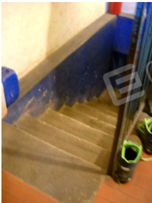
Scala d'accesso alla ex centrale termica comune
