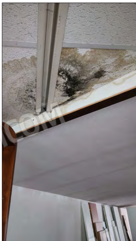
Particolare infiltrazioni/umidità
