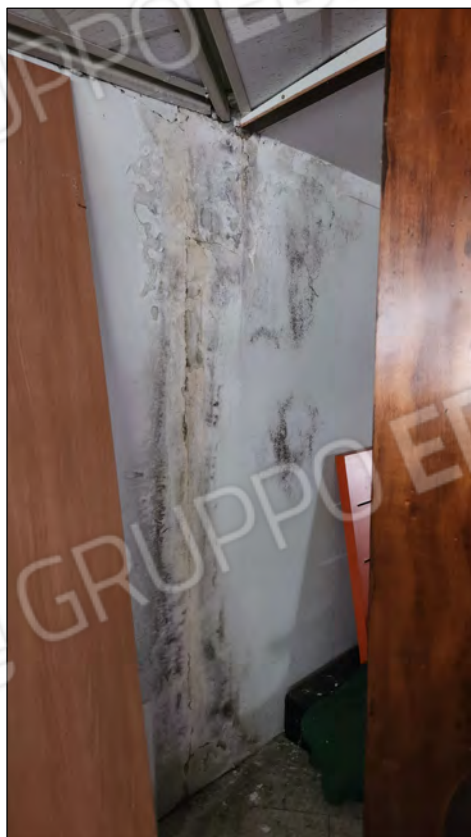
Particolare fessurazioni/umidità
