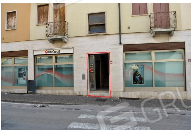
Foto 6 – via Liston San Gaetano – ingresso comune
