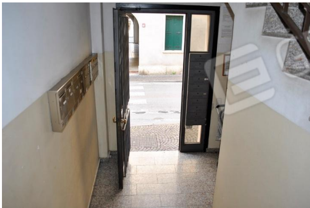
Foto 7 – ingresso/vano scale comune – P.T.
