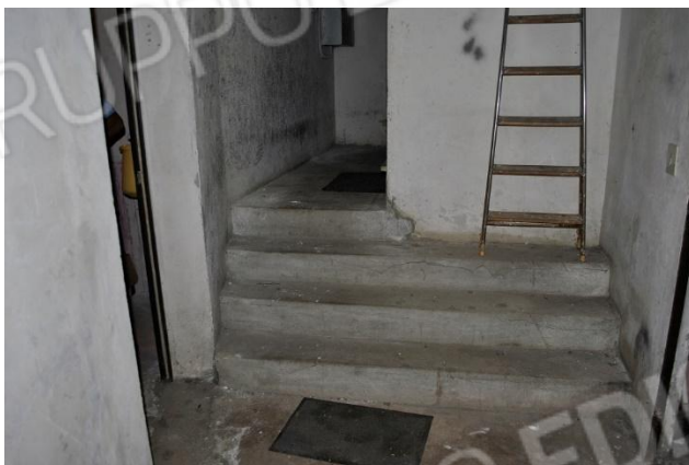
Foto 32 – corridoio comune – P.ST
