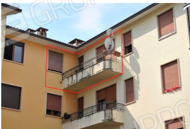
Foto 4 – vista da piazza A. De Gasperi - particolare
