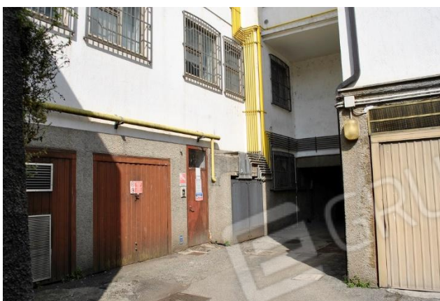
Foto 42 – spazio di manovra comune – P.ST
