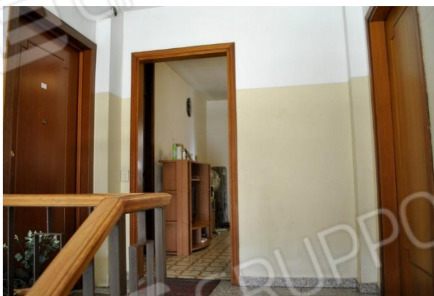
Foto 10 – vano scale comune – pianerottolo P.3
